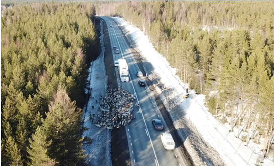
Bild 1 exempel från E4, bild från Trafikverket
