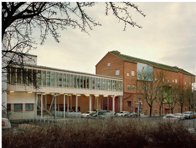
Figur 82. Gångbron som länkar samman den äldre skolbyggnaden med den nya svävar över marken. Foto: Johan Fowellin
