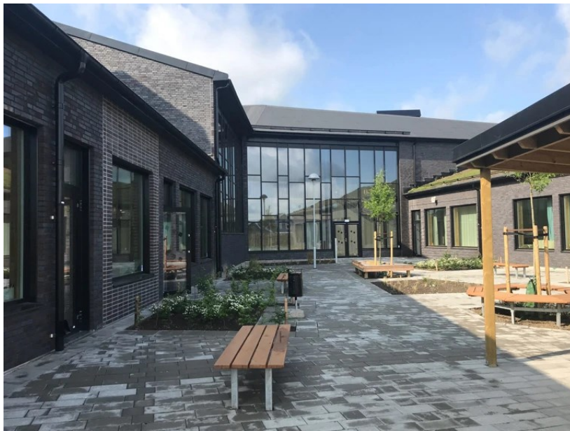
Figur 30. Tack vare byggnadens form har varje klassrum fått en dörr ut till ett utomhusklassrum som är plattsatt och inramas av låga häckar. Med tiden och med verksamhetens engagemang har dessa uteklassrum potential att utvecklas till fina entrézoner. På skolgården finns det även rinnande vatten och uteklassrum med tak som skyddar mot sol och regn. Foto: Linda Gustafsson Luthener
