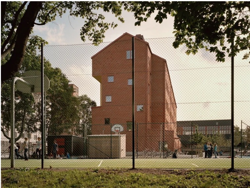
Figur 92. Gaveln på nya byggnaden med den nya multiarenan i förgrunden. Multiarenan är populär hos de kringboende i stadsdelen och samutnyttjandet sker utan konflikter med skolan. Foto: Johan Fowelin
