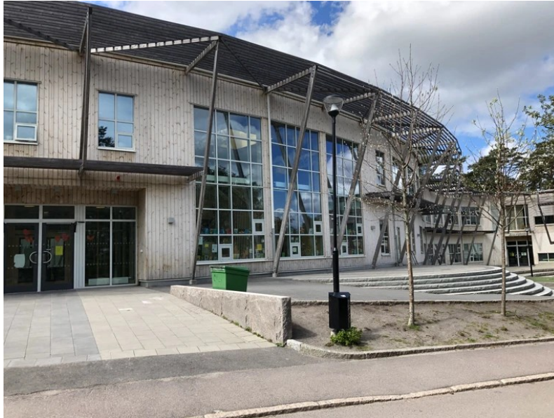
Figur 73. Skolbyggnaden är uppdelad i en mer publik del och en del enbart för skolans egen verksamhet. Närmaste i bild är entrén till den mer publika delen som rymmer allmänna funktioner som matsal, kök, personalrum, konferensrum, bibliotek och familjeklassrum. Till höger i bilden syns entrén till skolans egen verksamhet. Uppdelningen av byggnaden med separata entréer underlättar uthyrning av lokalerna och möjligheten för lokalsamhället att använda dem. Foto: Lena Jungmark/Boverket
