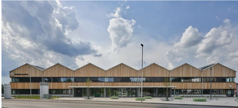
Figur 7. Adolfsbergsskolan har en tydlig profil med sågformat tak. Byggnaden karaktäriseras av stående lärkpanel och genomgående fönsterband. Foto: LLP Arkitekter Åke E:son Lindman
