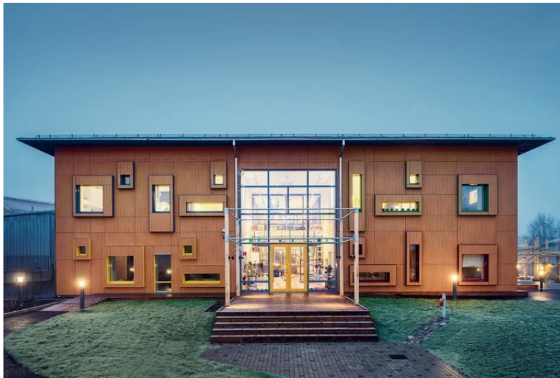
Figur 33. Förskolebyggnadens orientering och placering på tomten ger goda ljusförhållanden och siktlinjer genom byggnaden. Trots sin kompakta volym får rummen direkt dagsljus från de stora fönstren och ljusgården. Byggnadens fasad karaktäriseras av fönster i olika färger, storlek och djup. Foto: Felix Gerlach
