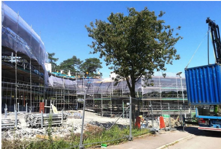
Figur 8. Byggande av Landamäreskolan i Göteborg. Foto: Åke E:son Lindman
