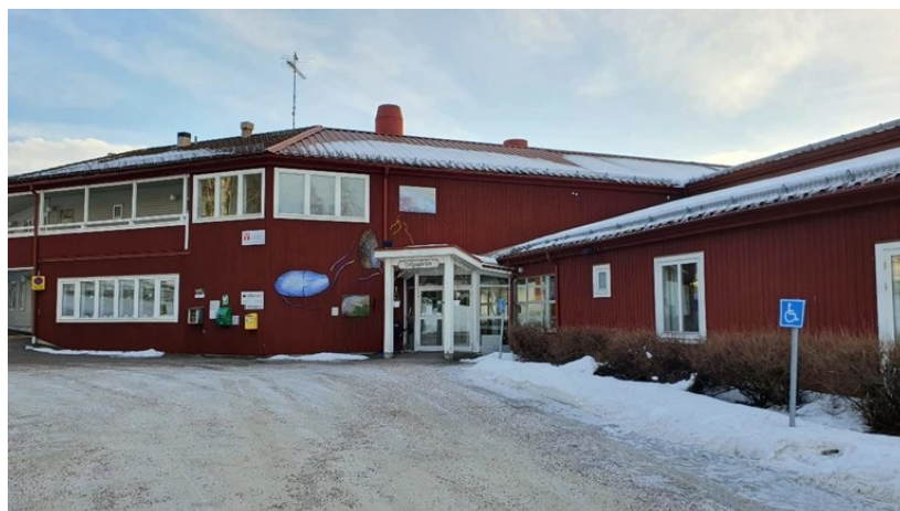
Figur 33. Svågagården i Ängebo rymmer förutom skola, förskola och fritidshem, även äldreboende, mötesrum för kommunalnämnden, hemtjänst, Folkets hus, kyrksal och bibliotek. Samnyttjandet av lokalerna är en förutsättning för att alla verksamheter ska kunna finnas i Svågadalen och Svågagården fungerar dessutom som en mötesplats mellan generationer. Foto: Cecilia Svensson
