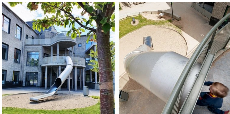
Figur 21. Björkhagens förskola i Malmö som från plan två har en rutschkana ner till gården som komplement till trappan. Arkitekt: New Line arkitekter. Foto: Maria E Teder/Boverket (vänster) och Werner Nystrand (höger).
