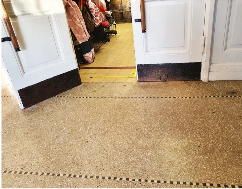
Figur 92. Ett stengolv kan ofta fungera väl i över 100 år. Sorgenfriskolan i Malmö. Foto: Maria E Teder/Boverket
