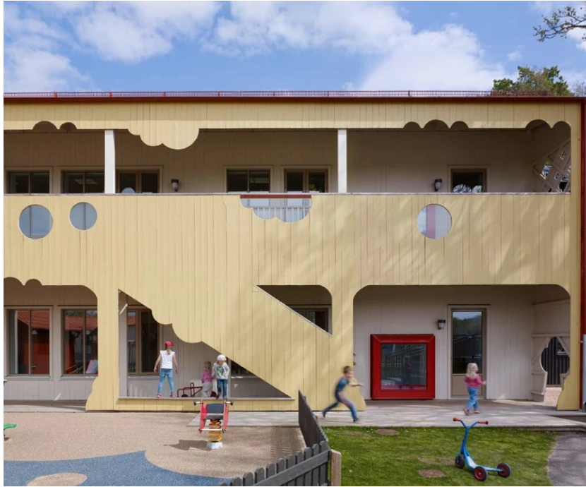
Figur 62. På Hemsjö skola i Alingsås är zonen närmast byggnaden skyddad av tak. Här är det nära till lekmiljöer för mindre barn och sittplatser där man kan hänga och prata med en vuxen. Arkitekt: Okidoki. Landskapsarkitekt: Norconsult. Foto: Bert Leandersson
