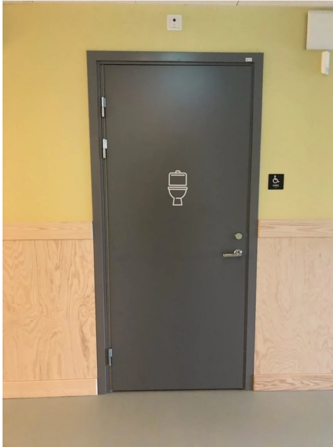
Figur 110. Tydlig ljushetskontrast mellan toalettdörr och omgivande vägg på Brogårdaskolan i Bjuv. Arkitekt: Codesign. Foto: Angelica Åkerman/Boverket.
