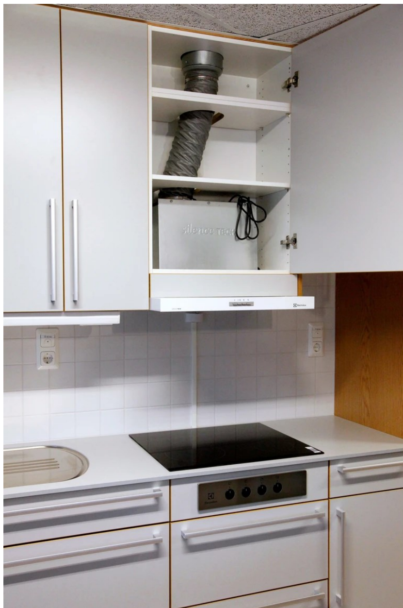
Figur 2. Bilden visar exempel på köksventilation. Fotograf: Jörgen Ragnarsson
