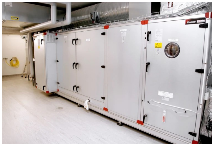
Figur 1. Bilden visar ett ventilationsaggregat. Foto: Jörgen Ragnarsson
