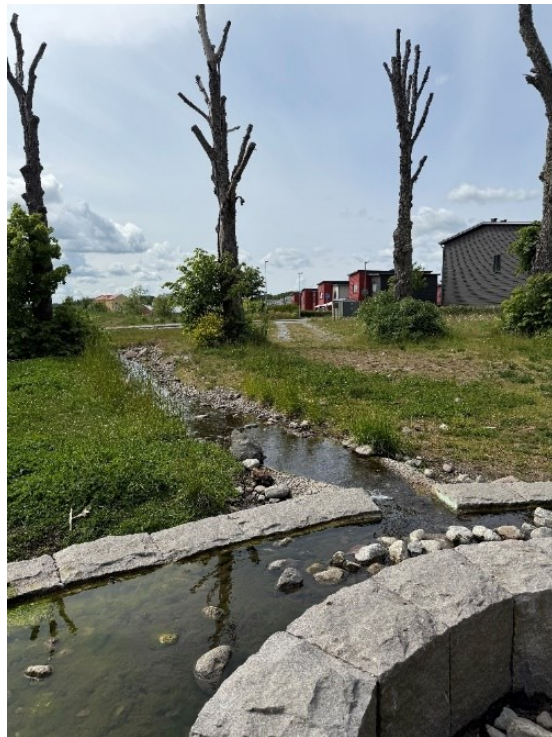
Figur 101. Eds Allé, Upplands Väsby kommun. Kommunen har tidigt arbetat med att samordna grön- och grå infrastruktur i Eds Allé, bland annat denna platsbildning som både omhändertar dagvatten och bidrar till rekreativa värden. Foto: Boverket.
