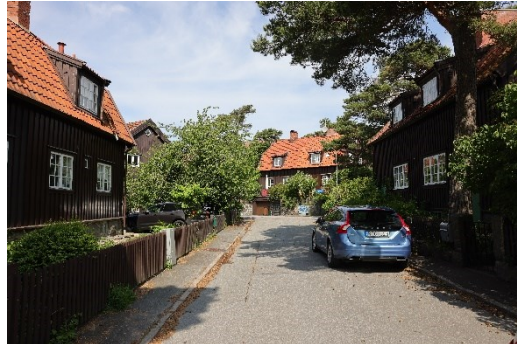
Figur 46. Landala Egnahem, Göteborgs kommun. Foto: Boverket.
