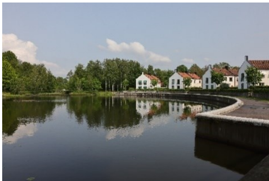
Figur 116. I den södra delen av Biskopshagen ligger bebyggelsen placerad runt den damm som utgör en teknisk anläggning för reglering av vattennivån i Växjösjön. Dammen omges av ett promenadstråk som kopplar an till ett stråk som sträcker sig runt hela Växjösjön.
