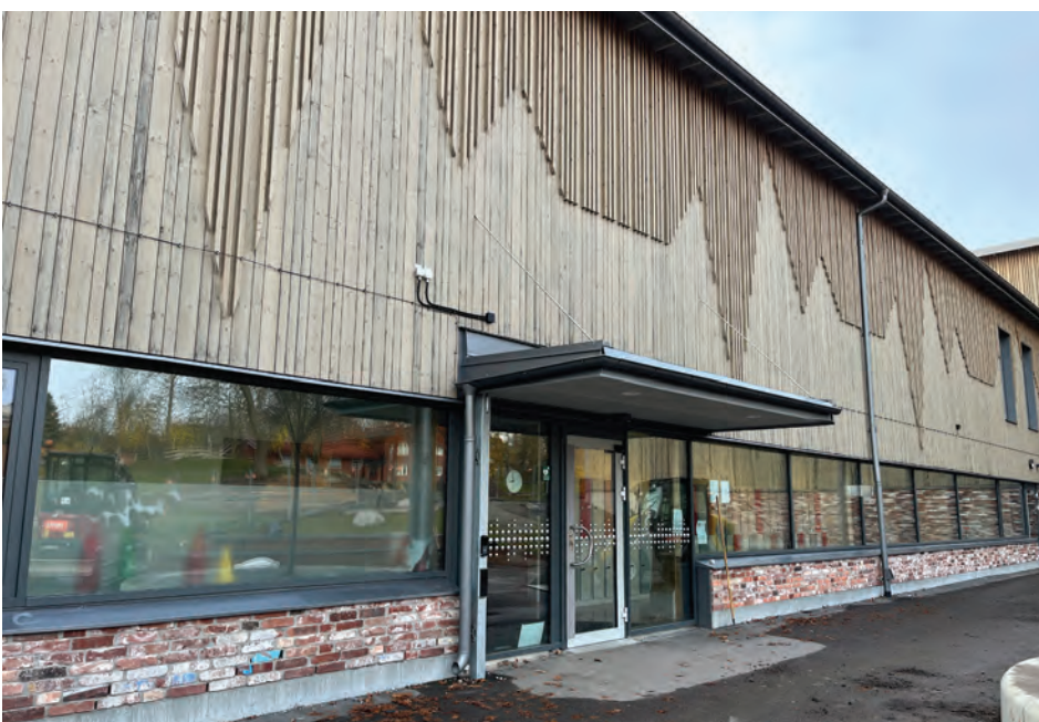
Bild 168. Långa fönsterband. Långa fönsterband i fasad ger ljus korridor inne. Foto: Mirja Ranesköld/Boverket.
