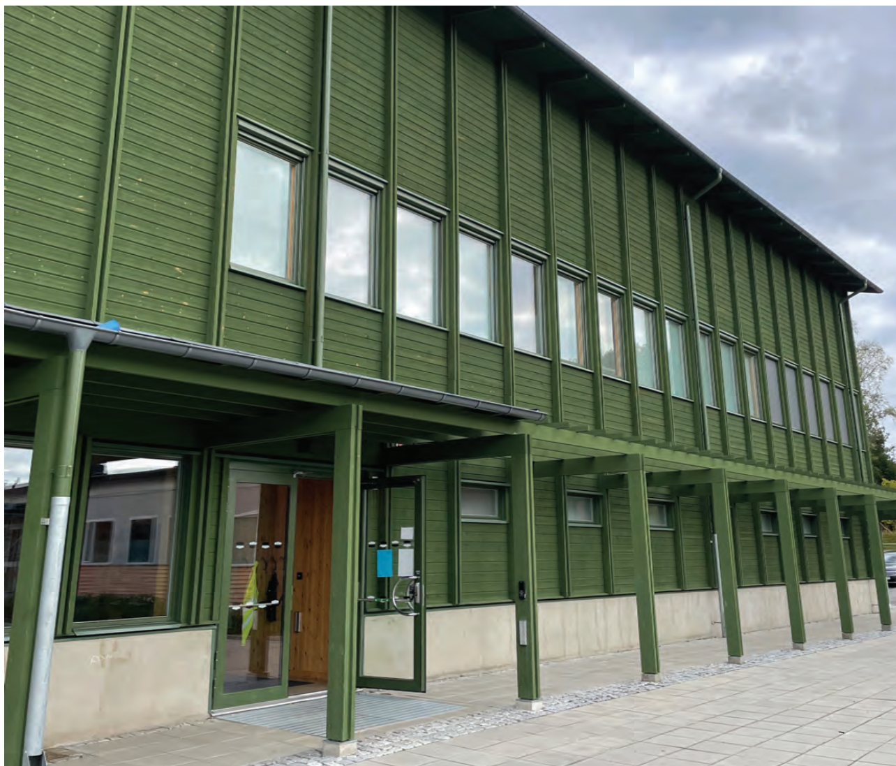
Bild 172. Entré till idrottshallen. Med pergolan upplevs byggnadshöjden lägre, samtidigt som den ger skugga. Foto: Hans Lindgren/Boverket.
