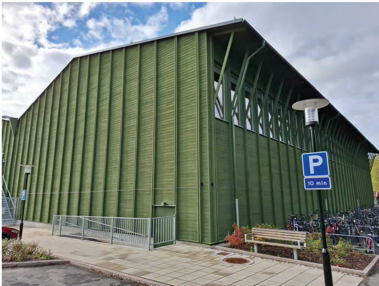
Bild 177. Fasad med liggande träpanel och stående ribbor. Foto: Hans Lindgren/Boverket.
