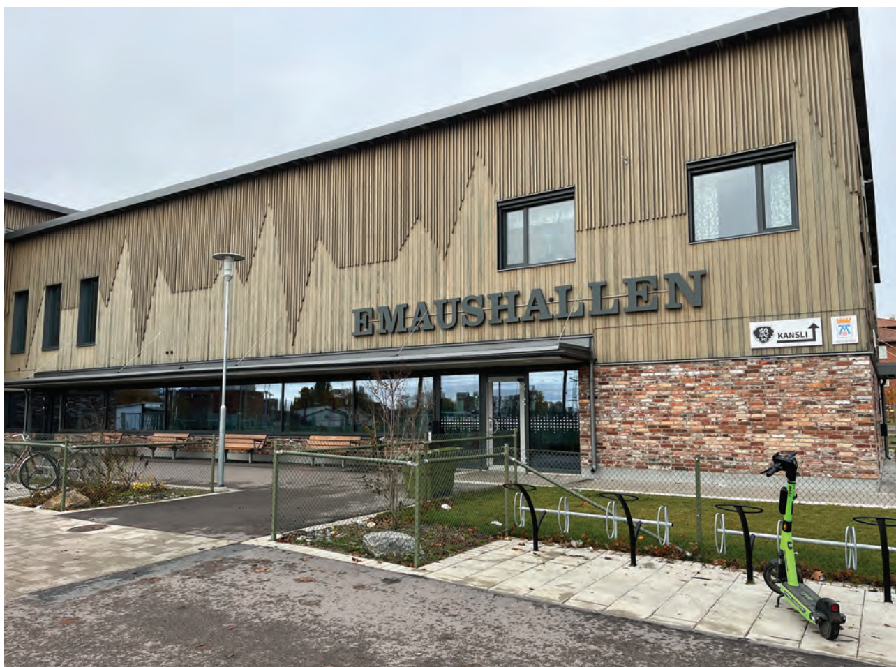
Bild 162. Entré. En av entréerna till Emaushallen. Foto: Mirja Ranesköld/Boverket.
