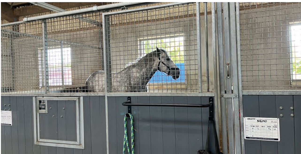
Bild 62. Stallet. Ytterväggar av betong, så högt som hästarna når. Däröver perforerad plåt för ventilation. Fönster i varje box. Tak av fibercement. Foto: Mirja Ranesköld/Boverket.
