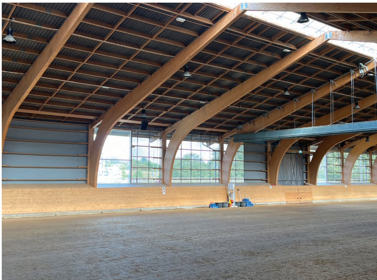
Bild 188. Ridhuset. Kanalplastskivor i taknocken för ljusinsläpp. Foto: Mirja Ranesköld/Boverket.
