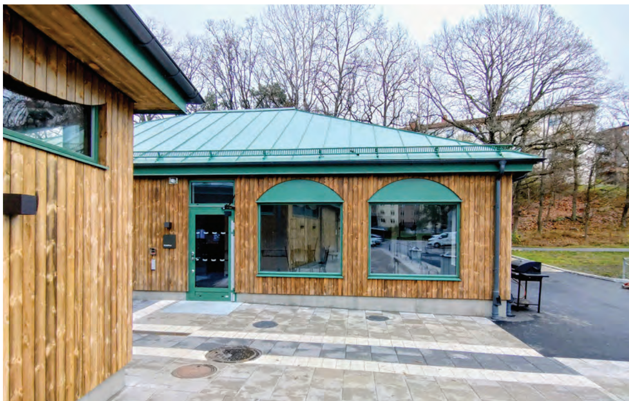
Bild 44. Byggnaden rakt fram har samlingsrum, café, kansli, förråd samt toaletter. Till vänster den separata omklädningsbyggnaden. Foto: Yvonne Egnér/Boverket.
