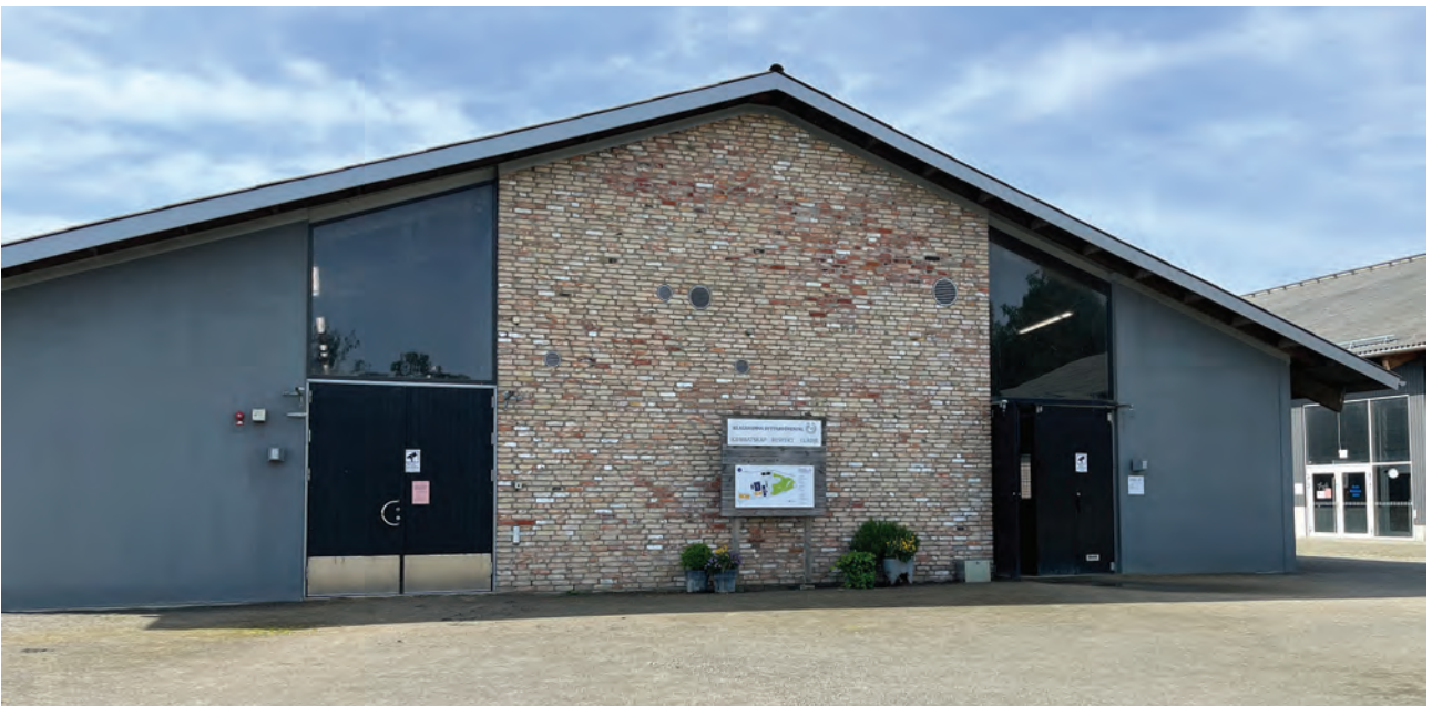
Bild 71. Gaveln på stallet. Återbrukat tegel i kombination med betongelement och stora fönsterpartier över dörrarna. Foto: Mirja Ranesköld/Boverket.
