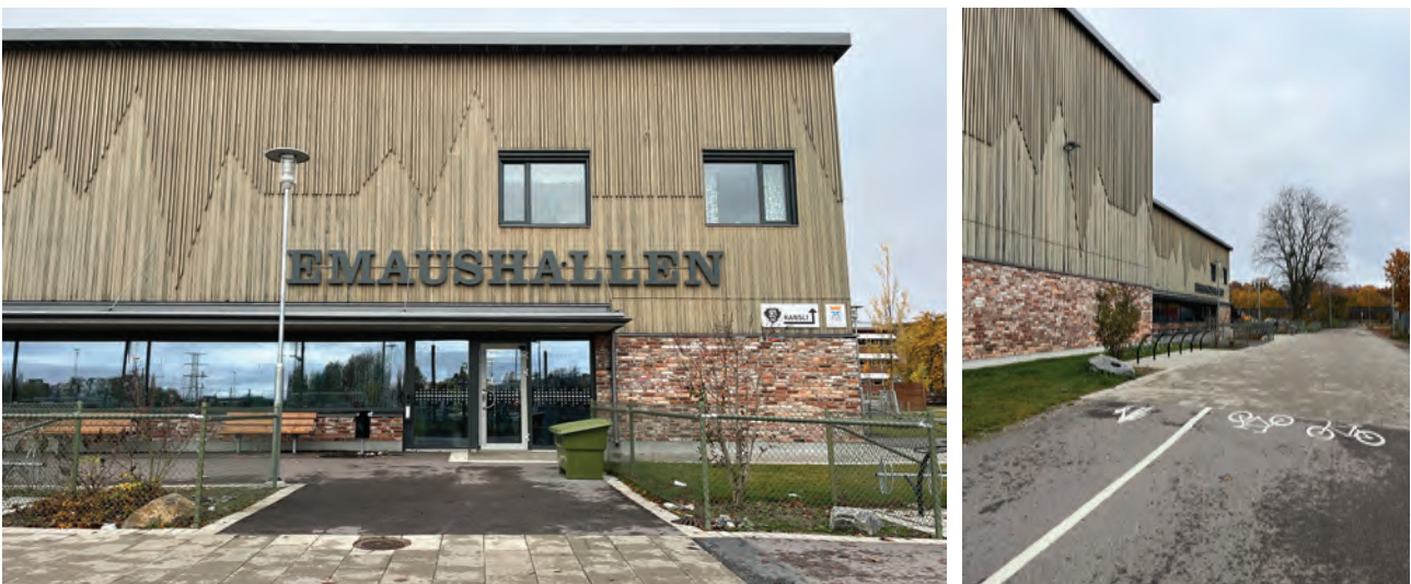
Bild 166. Pulskurvan. Pulskurvan på fasaden vandrar runt byggnaden Entrén sedd från gång- och cykelbanan. Under taket finns sittplatser. Foton: Mirja Ranesköld/Boverket.
