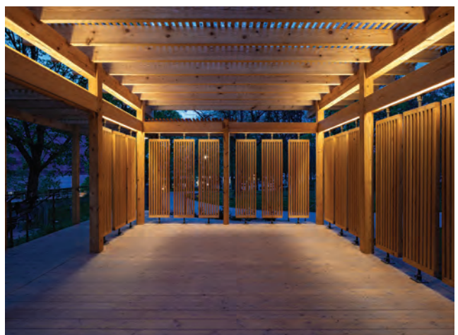
Bild 155. På kvällen lysas Yogapaviljongen upp av ett mjukt ljus från dolda armaturer. Foto: Thomas Wingstedt/Nyréns
