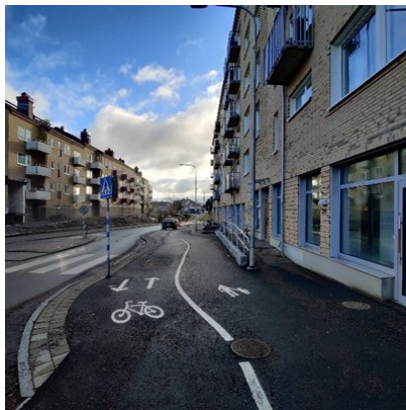
Fönster och entré vetter ut mot gatan. Dessutom separerad gång- och cykelbana. Foto: Teodor Wester/Boverket.
