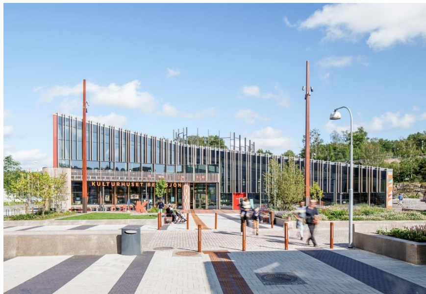
Kulturhuset Bergsjön. Arkitekt: Sweco Architects. Foto: Felix Gerlach
