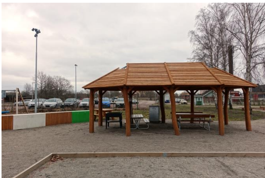
Grillhuset som har placerats nära lekområdet. Foto: Boverket
