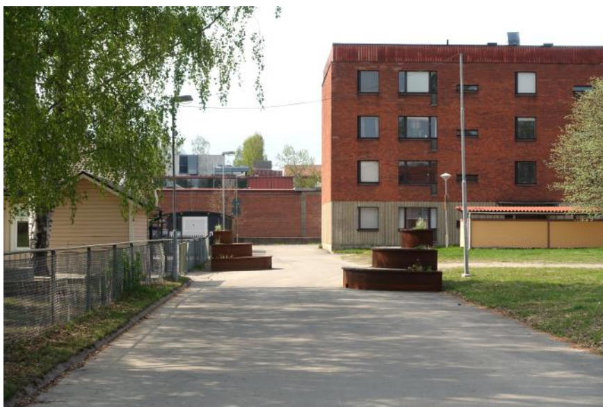
Gatumöbelns placering utanför förskolan. Foto: Boverket
