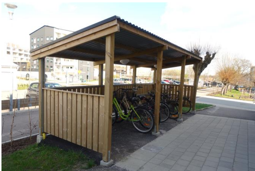
Cykelparkering. Foto: Boverket
