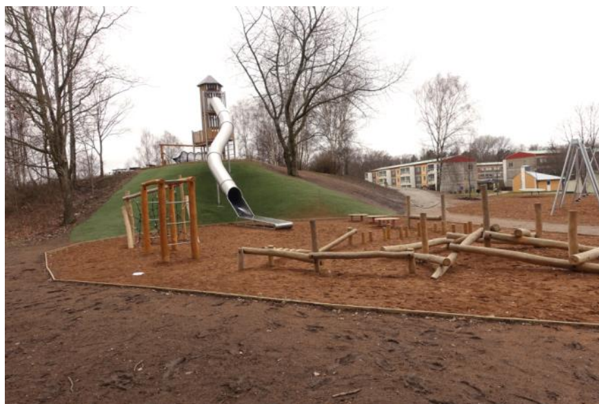
En tubbrutschkana och en balans- och motorikbana. Foto: Boverket
