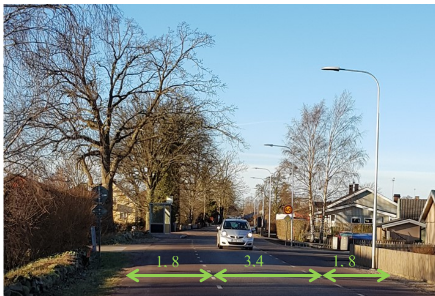
Smedbyvägen omdisponerades så att körbanan nu utgör 3,4 meter och gång- och cykelvägen 1,8 meter på vardera sidan om körbanan. Foto: Boverket.
