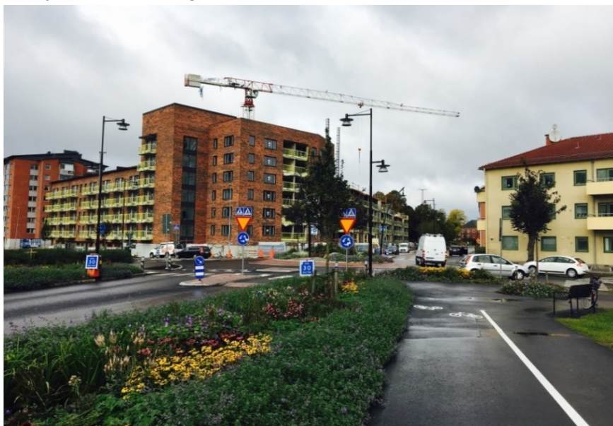
Nybyggnation av flerbostadshus i korsningen Eriksbergsgatan – Linnévägen. Foto: Katrineholms kommun
