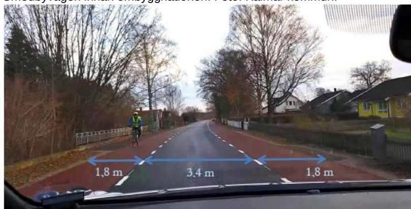
Smedbyvägen efter ombyggnationen. Foto: Kalmar kommun
