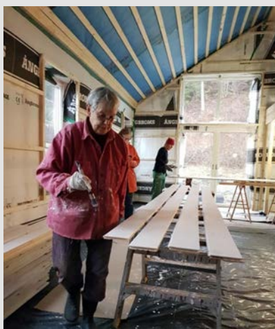
Målning av brädor till tak och innerväggar.
