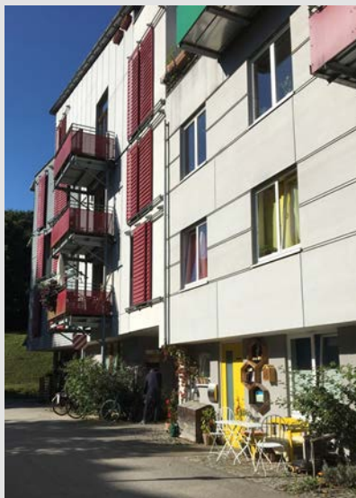
Det första passivhuset i Tübingen uppfördes av en byggemenskap i Französisches Viertel 1999.
