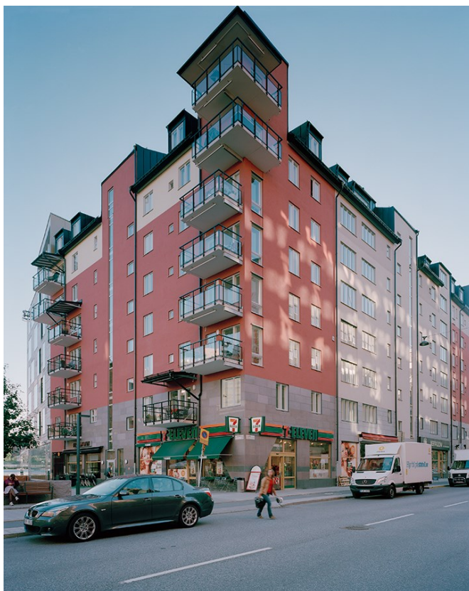
Hörnhus med balkonger på Lilla Bantorget i Stockholm. Arken Arkitekter AB. Byggare Skanska Hem. Stadsarkitekten ville att varje trapphusenhet skulle ges individuell utformning, vilket ordnades genom att olika arkitekter på kontoret sattes att ansvara för respektive trapphus. Foto: Alexander de Cluveland
