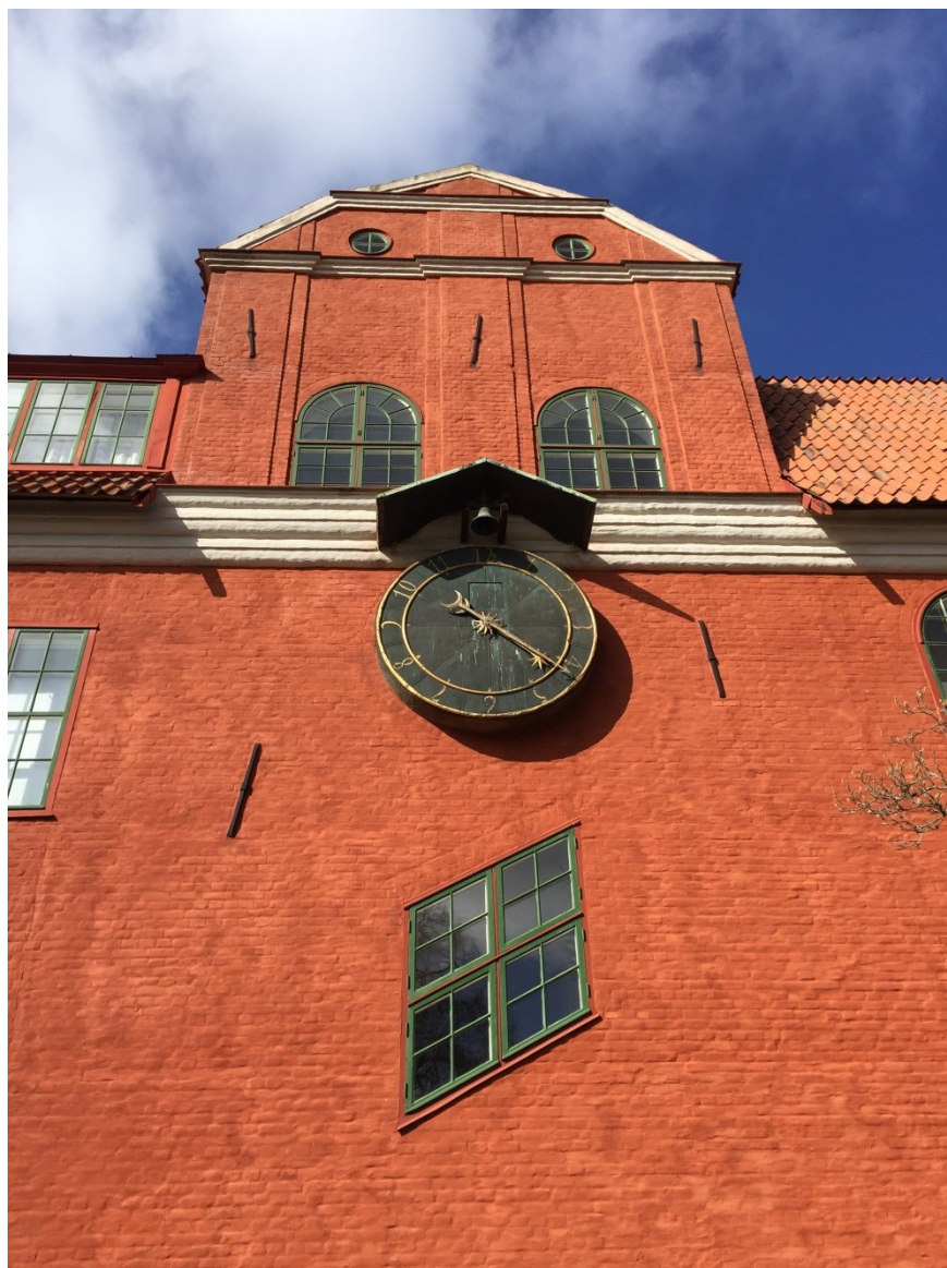
Väggaskolan i Karlshamn. Arkitekt Erik Gunnar Asplund. Foto: Emina Kovacic
