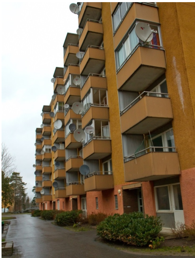
Miljonprogramsområdet Hovsjö i Södertälje uppfördes 1973–1975, ett område som länge haft dåligt rykte men som nu genomgår en stor satsning genom det kommunala fastighetsbolagets försorg. Foto: Johan Kihlberg.
