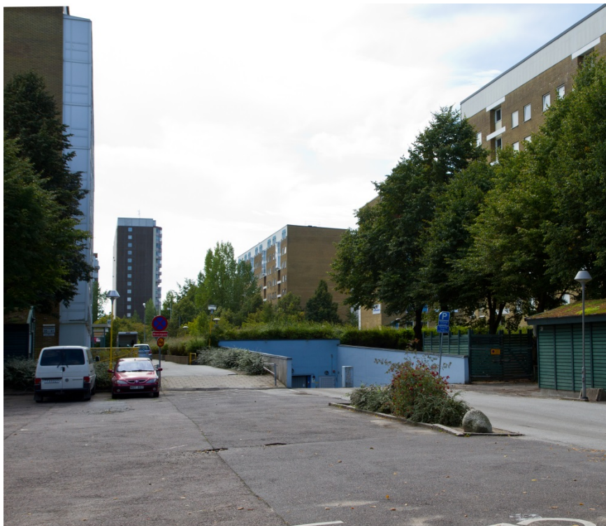
Många storskaliga miljonprogramsområden har delar som motsvarar den bild många har av miljonprogrammet som präglad av höga hus, betong och stora parkeringsytor...
