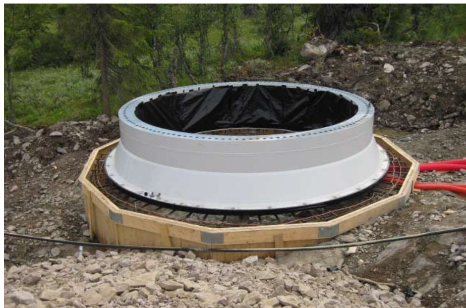
Rock Adapters. Bergsför- ankrat fundament. Foto: Thomas Modin.
