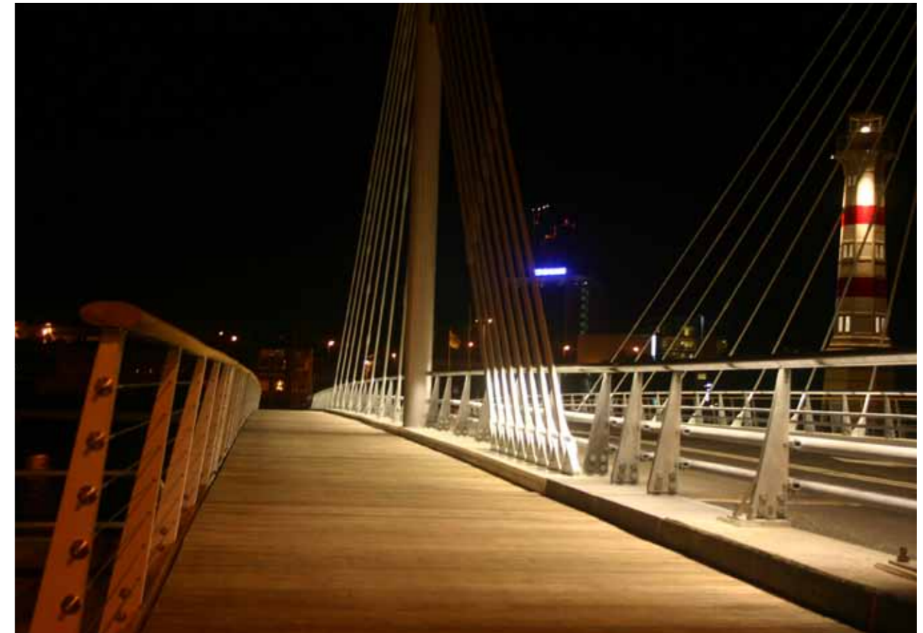
Brons ljuskällor är infällda i broräcket och skyddas på så sätt mot skadegörelse. Samtidigt underlättar den valda tekniken orientering och överblickbarhet.
