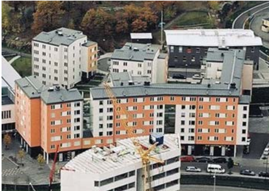
Kv. Vågskvalpet, fasad mot Skeppsmäklaregatan sett från ovan.
