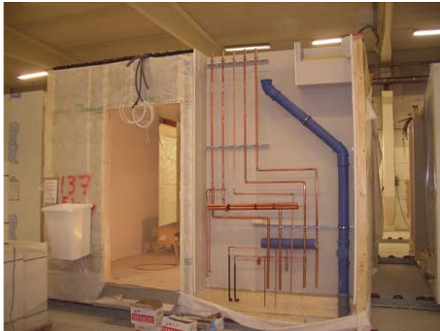
Figur 16 Installationer i ett volymelement i fabriken
