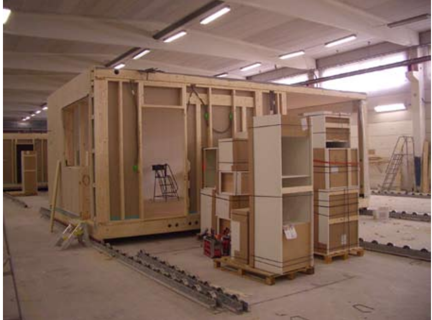
Figur 18 Volymelementen utrustas med köksinredning i fabriken
