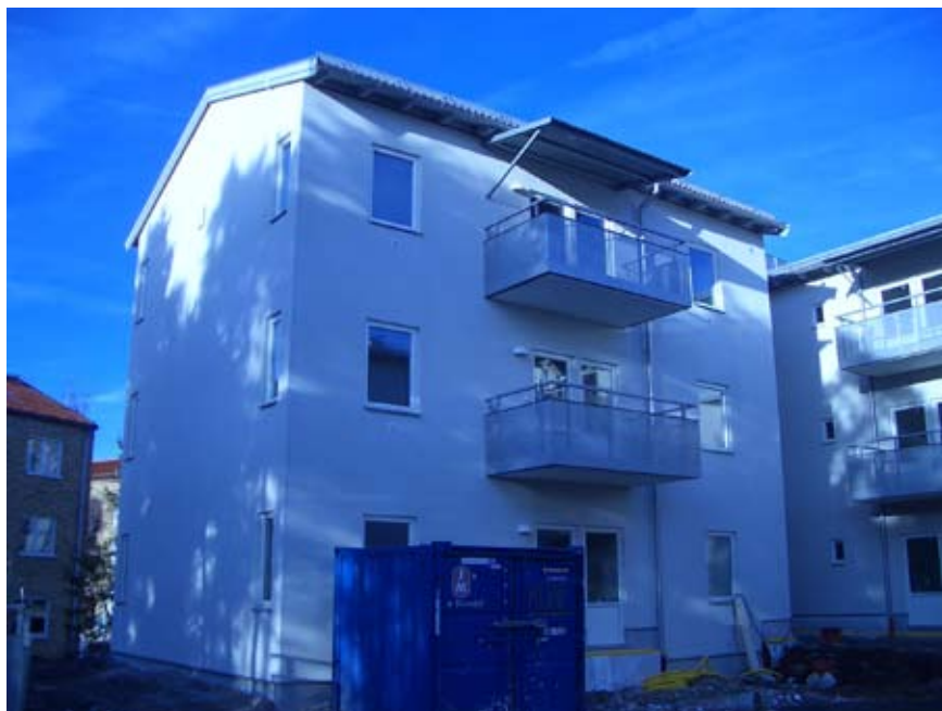
Figur 22 Ett av de färdigställda bostadshusen i projektet
