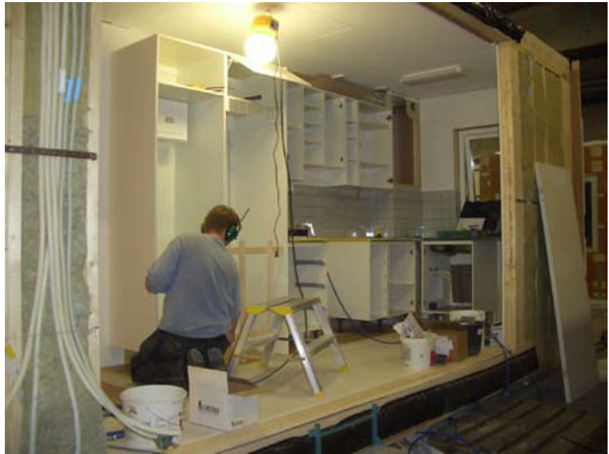
Figur 38 Montering av skåpsinredning i ett volymelement i fabriken
