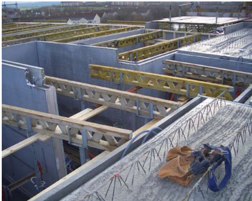
Figur 26 Den bärande stommen av betongelement monteras på byggplatsen
