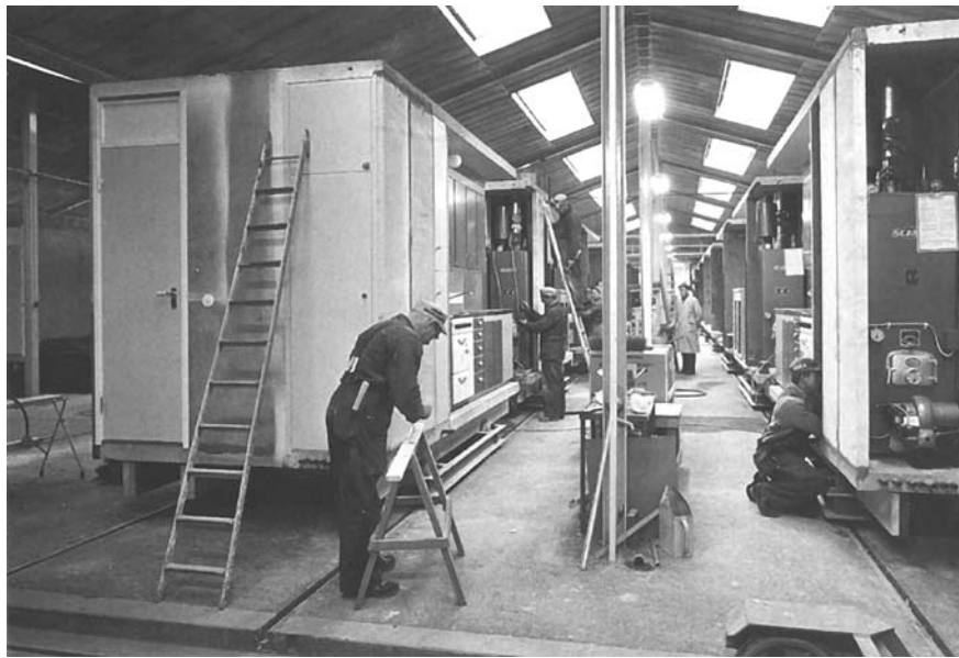
Figur 8 Ett förtillverkat kök i ett volymelement tillverkat under 1960-talet 61
