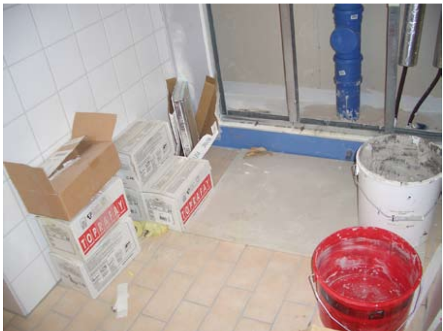
Figur 21 Kompletterande arbete i badrum på byggplatsen
