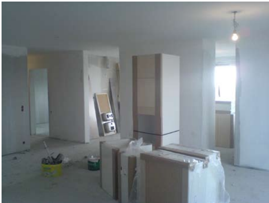
Figur 29 Köksinredning inför montage på byggarbetsplatsen
