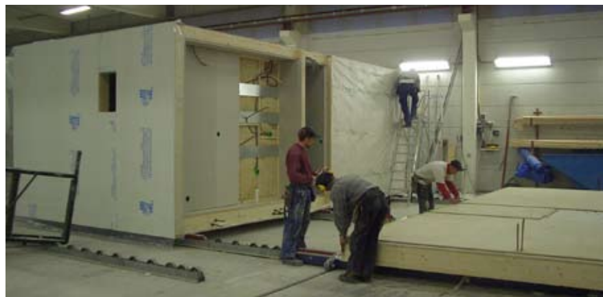
Figur 15 Bjälklags- och väggelement sätts samman till volymelement
