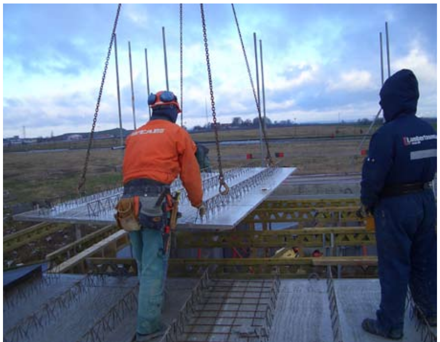
Figur 25 Montage av betongelement
