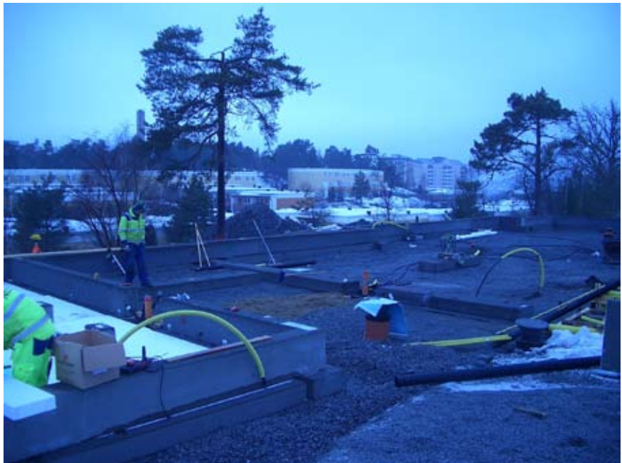
Figur 39 Grunden till husen byggs med förtillverkade betongelement
