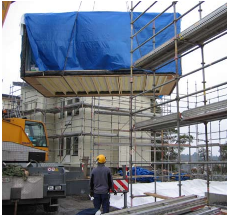
Figur 40 Ett volymelement monteras på byggsplatsen
