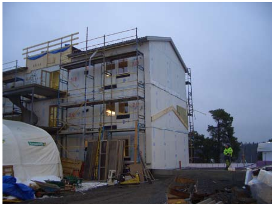
Figur 19 Volymelementen monterade på byggarbetsplatsen
