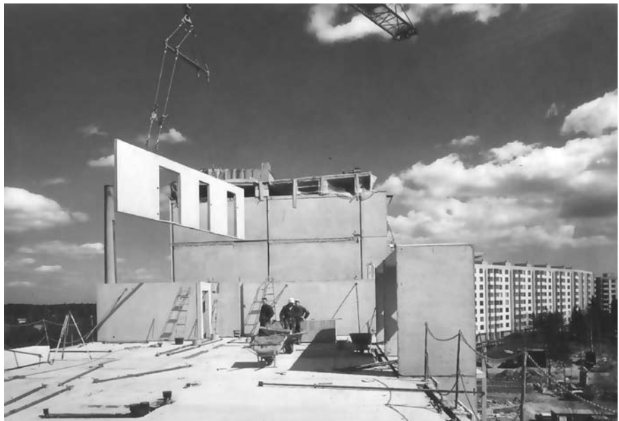
Figur 7 Systembyggande med betongelement under Miljonprogrammet 44
