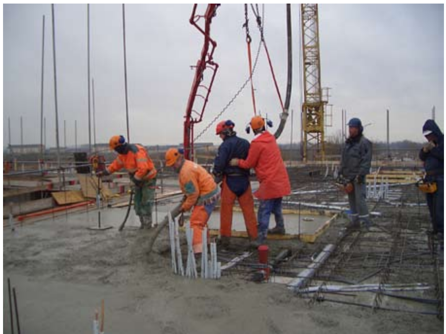
Figur 28 Bjälklagen består av förtillverkade plattbärlag som färdigställs med platsgjuten betong
