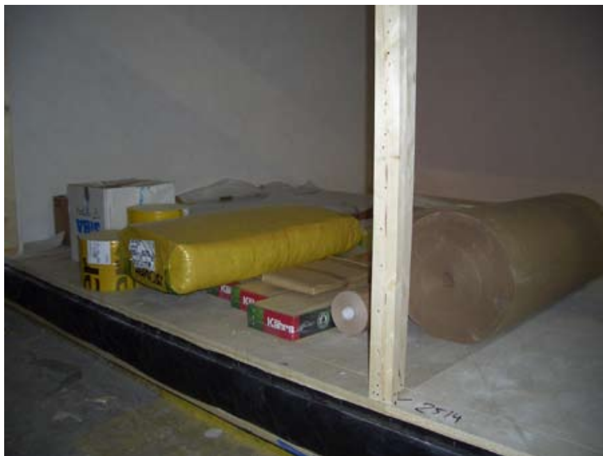
Figur 35 Material packas i volymelement inför transport
