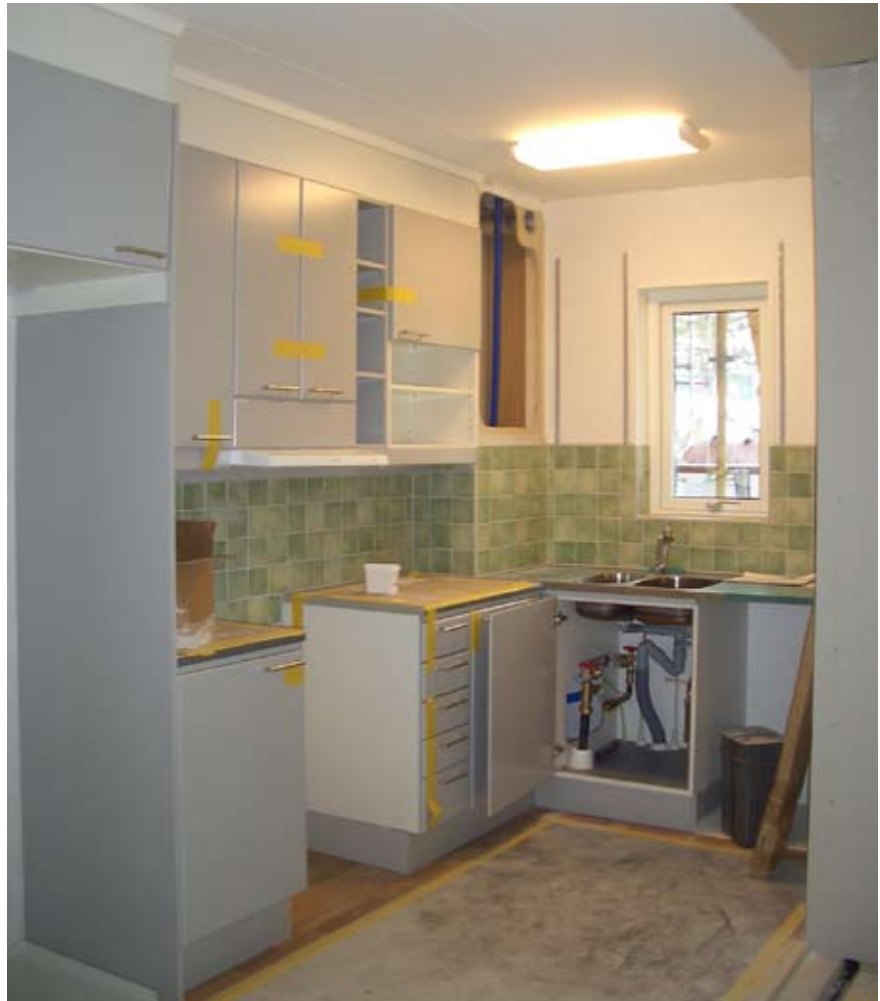
Figur 41 Köken är färdiga från fabrik och ska endast kopplas in på byggsplatsen
