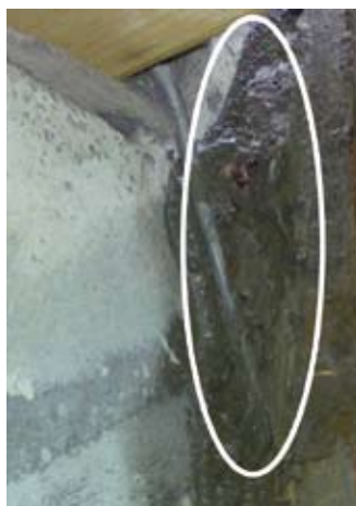
Gjutspill kortsluter elastiskt upplagd trappa mot trapphusplan.
