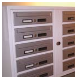
Värmepumpar och postfack är exempel på stomljudsallstrande installationer.
