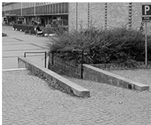
Bild 3.41 Dåligt exempel på en omarkerad ramp, Fridhemstorget i Malmö
