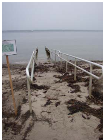
Aluminiumramp vid Vikingstrand badplats. Bilderna från Vikingstrand badplats är tagna efter badsäsong och som framkommer av bilden ovan ansamlas lätt sand, alger och sjögräs på rampen.
