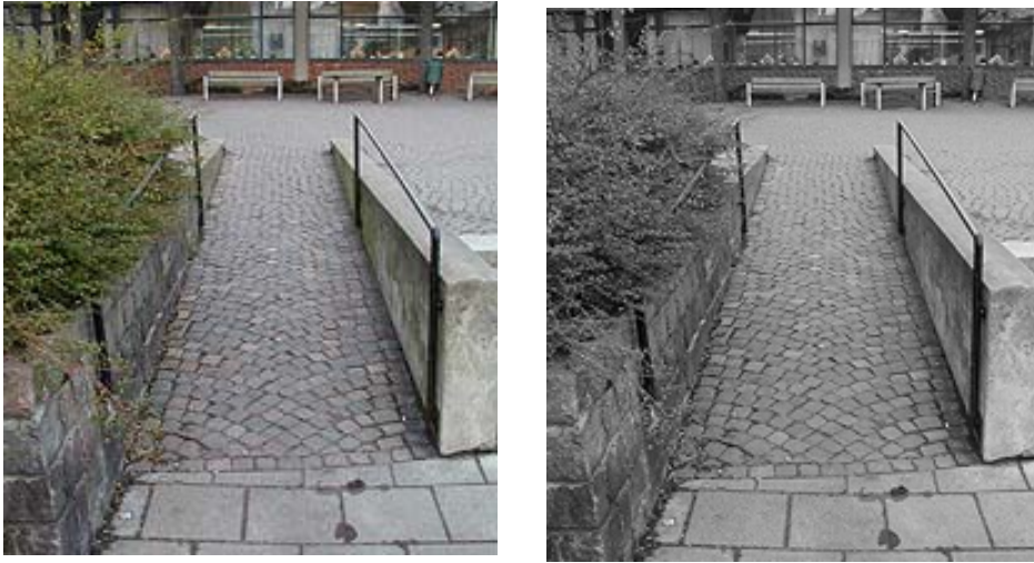
Bild 3.42 Dåligt exempel på en omarkerad ramp
