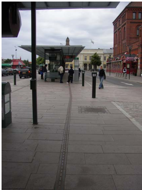
Malmö centralplan. Hur ledstråk bäst utformas så att de både är taktilt kännbara och har tillräcklig ljushetskontrast studeras just nu i ett projekt som Vägverket driver. I detta exempel från Malmö är inte ljushetskontrasten tillfredsställande.
