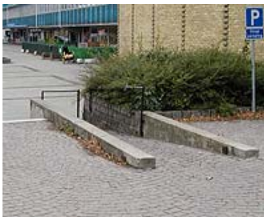
Bild 3.41 Dåligt exempel på en omarkerad ramp, Fridhemstorget i Malmö
