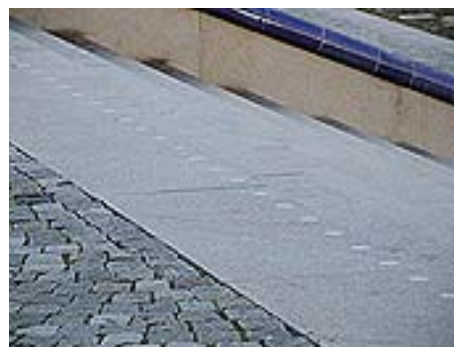
Bild 3.30 Dålig ljushetskontrast på första plansteget.
