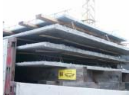
Fig 4. Leverans av plattbärlag
