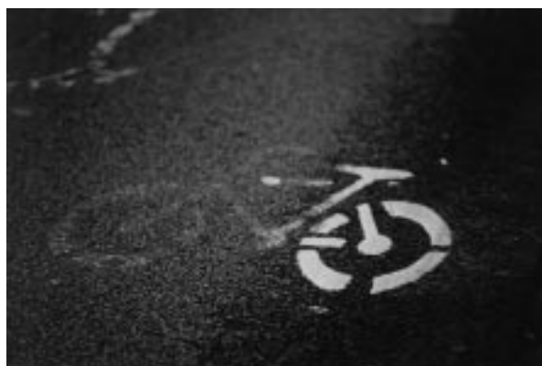
Figur 2. Ett cykelfält som endast avskiljs från annan trafik genom en målad linje kan invagga cyklisten i en falsk säkerhet. Definitionen av cykelbana enligt fallstudie Helsingborg Nordost inrymmer inte sådana lösningar.
