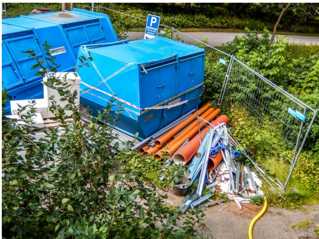
Figur 96. Containrar vid pågående stambyte. Foto: Mostphotos
