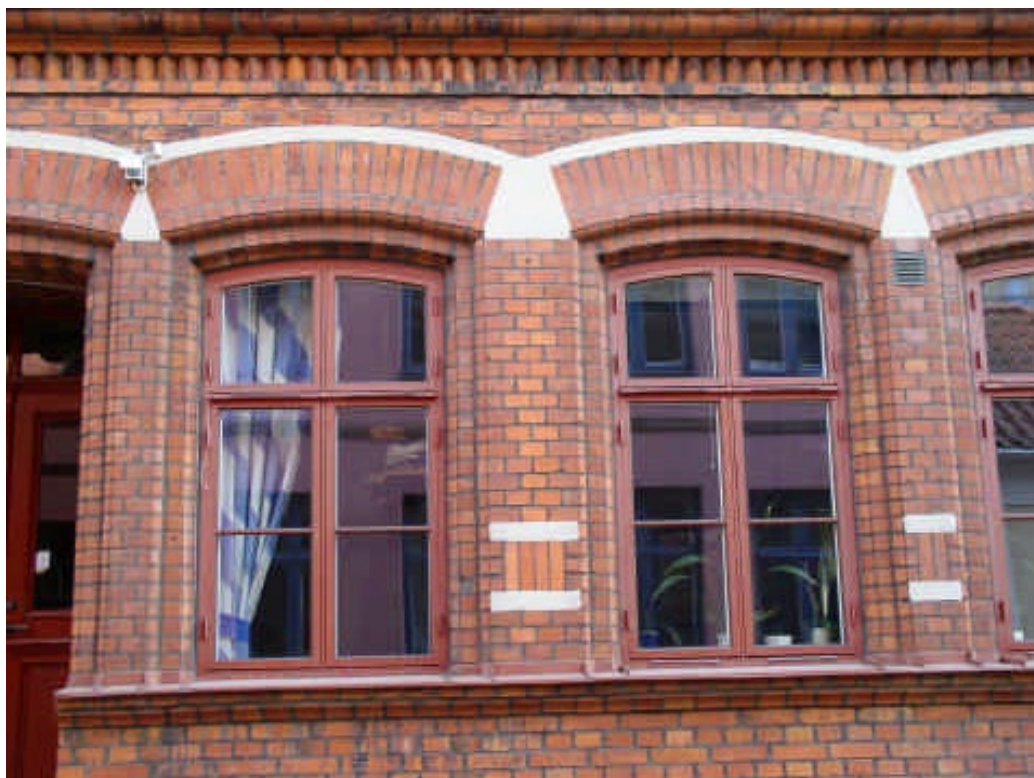
Moderna fönster med planglas och moderna beslag, men ursprunglig indelning.
