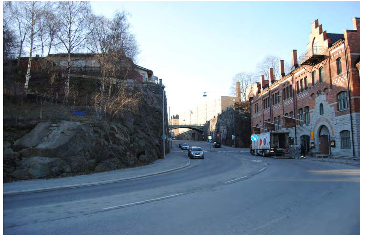
Här bildar berget en portik upp mot Lundabron och Hornsgatan när Torkel Knutssons gatan vrider sig runt bergsskärningen.
