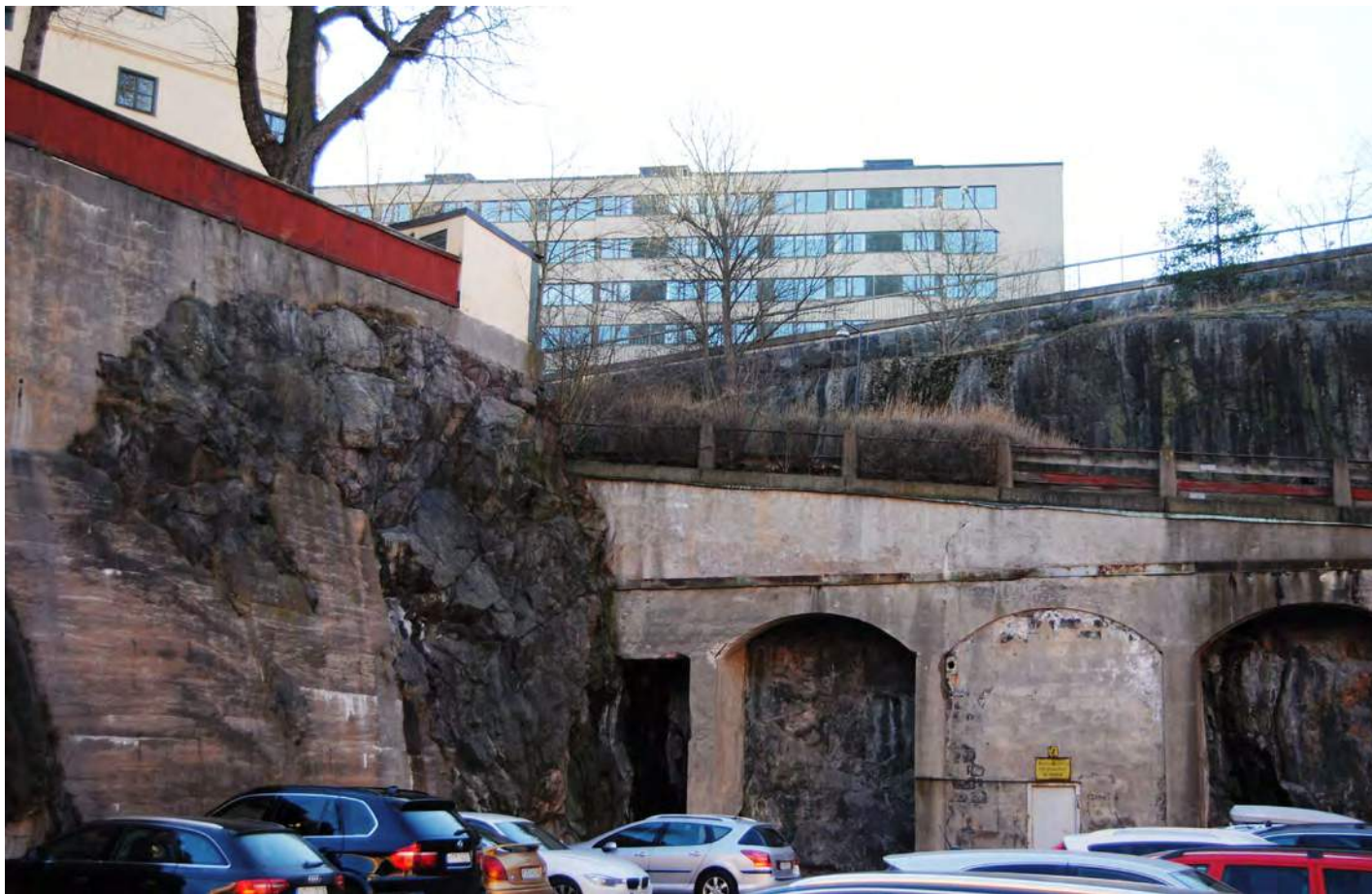
Vid Munchenbryggeriet möter berget den stora nivåskillnaden med hjälp av betongmurar och en gångväg som löper på skrå längs med bergskärningen.
