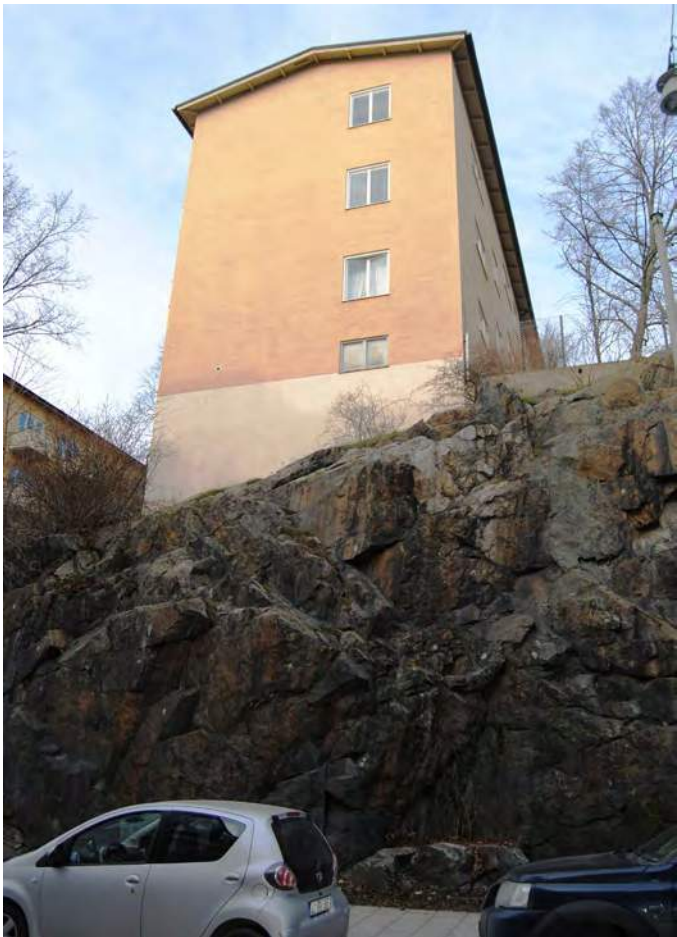
Bergsskärning mot Högbergsgatan, där bostadshuset tycks balansera uppe på berget.
