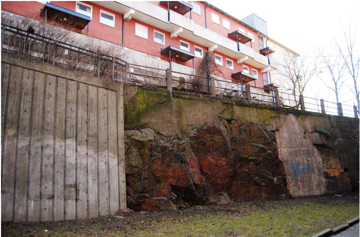
Bergskärning med betonginslag vid Maria Prästgårdsgata.
