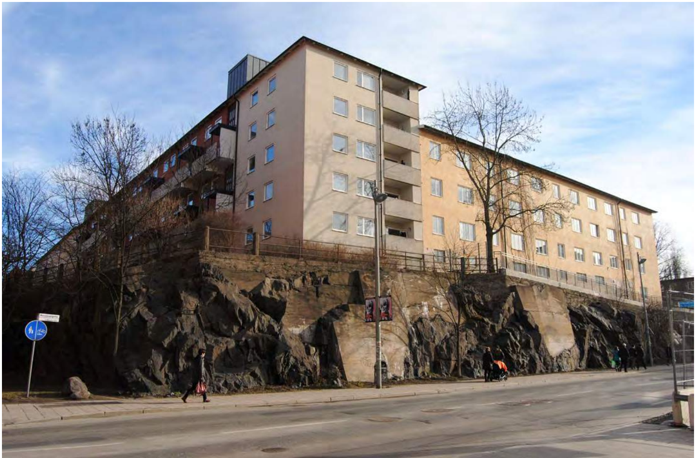
Bergsskärning mot Rosenlundsgatan, där den bevarade bergsknallen skjuter ut som en tunga mellan Maria Prästgårdsgata och Högbergsgatan.
