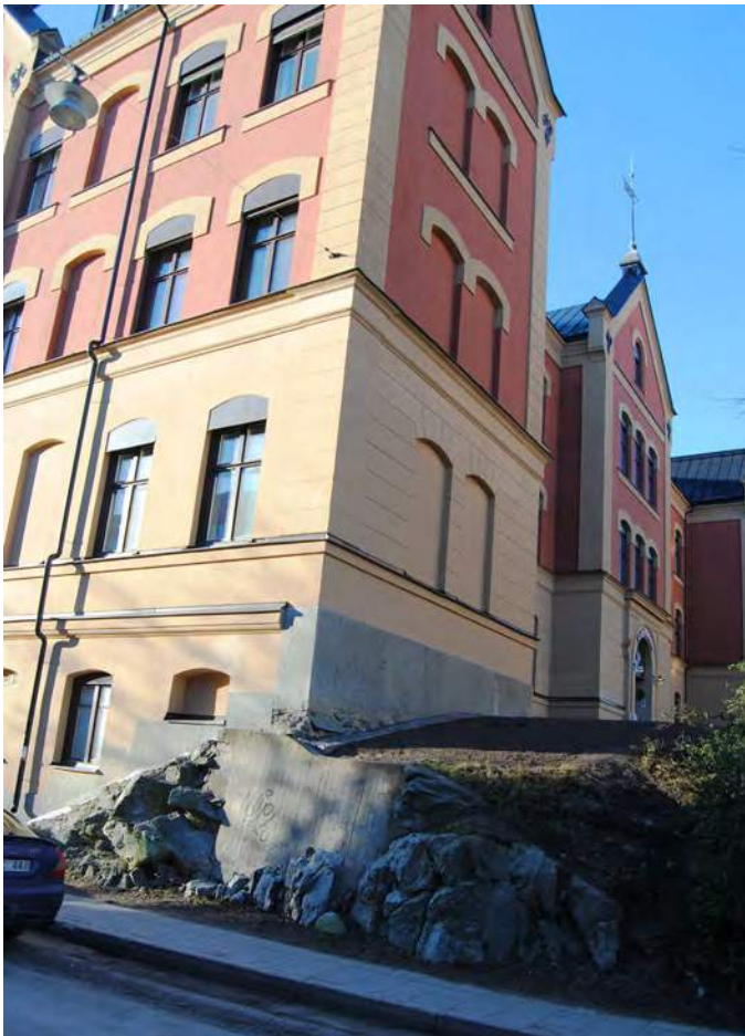
Sjukhusbyggnaden vid Rosenlunds sjukhus - kv. Vattenpasset 14 - är till delar byggt på berggrund.
