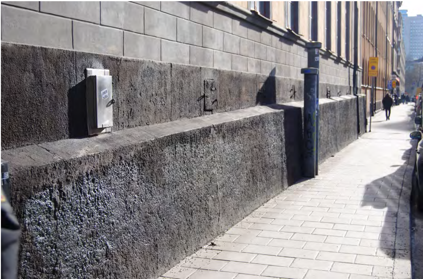
Då Almgrens sidenväveri - kv. Västergötland 6 - byggdes låg gatunivån betydligt högre. Sedan Repslagargatan sänkts har den bergsskärning som uppstått under huset putsades och gjorts prydlig så den närmast framstår som en del av byggnadens sockel.
