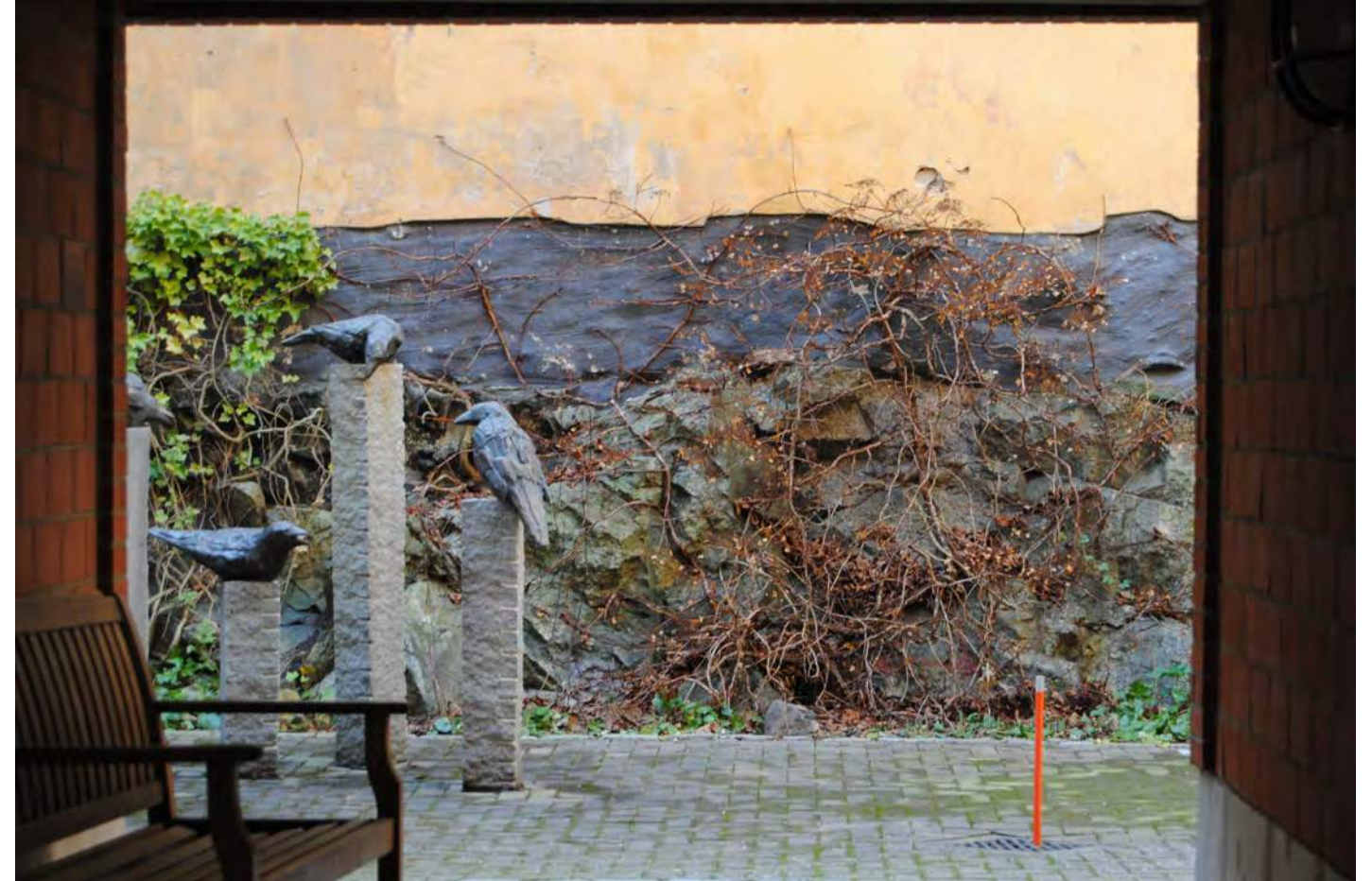
Äldre byggnad grundlagd på berg. Gårdsrum sett genom port från Skaraborgsgatan, kv. Östergötland 10.
