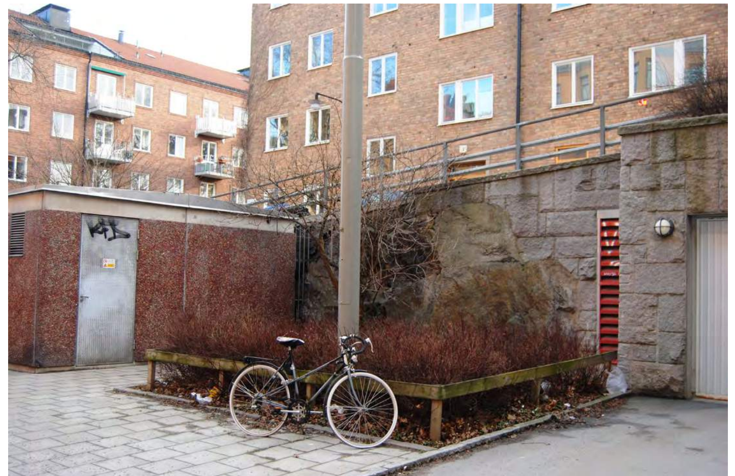
Berg som del av vägkonstruktion till Högbergsbacken klädd med granit.
