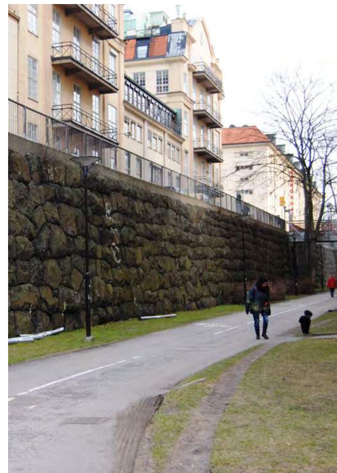
Murklädd bergsskärning i Änghästuparken. På den övre nivån löper Maria Bangata Längs - kv. Tobaksmonopolet 2-6.
