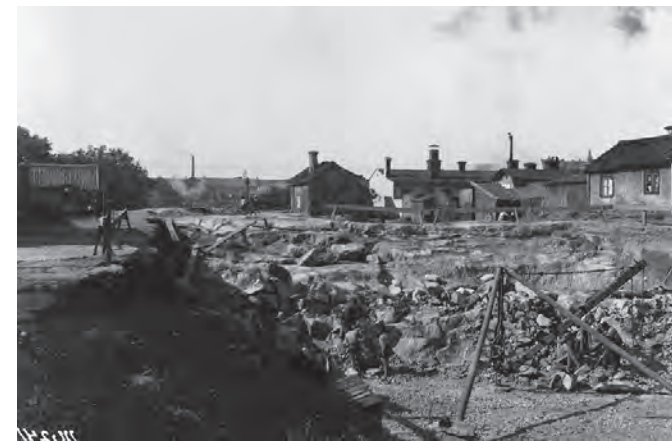
Sprängningsarbete för Rosenlundsgatans framdragande 1898 -1903, foto Kasper Salin. Källa: Stockholms stadsmuseum (SSM)
