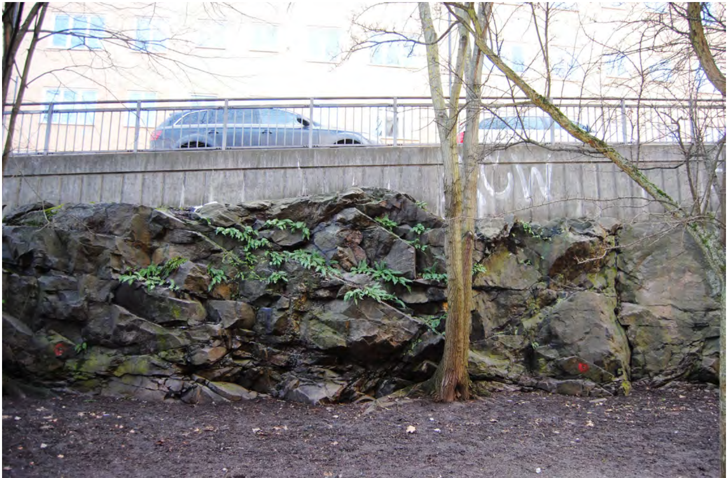
Bergsskärning mot Maria Prästgårdsgata, där berget klätts på med en övre stödmur mot gatan. En remsa med naturmark förstärker känslan av berget.
