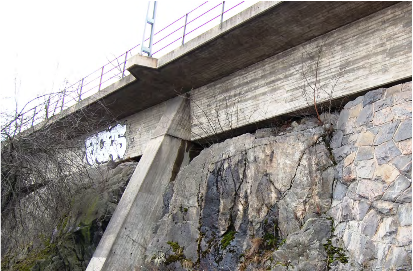
Saltsjöbanans brokonstruktion av armerad betong vilar på berg som skurits och som kompletterats med mur av vackert huggen granit.
