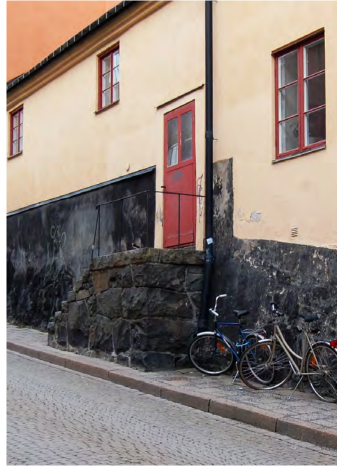
Huset på Kattgränd visar på bergets tidigare nivå.
