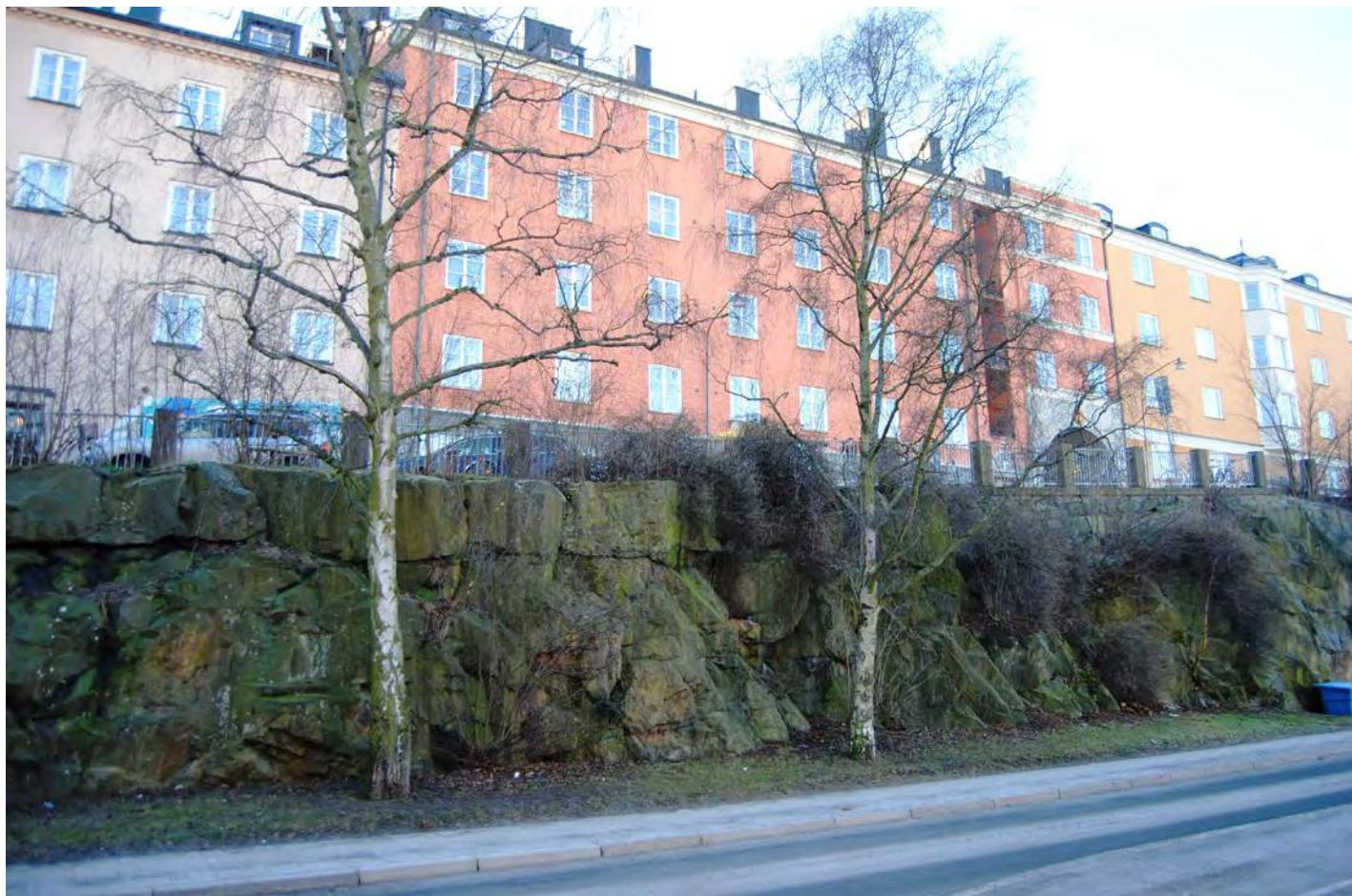
Bergsskärning mot Hallandsgatan ner mot Rosenlundsparken.
