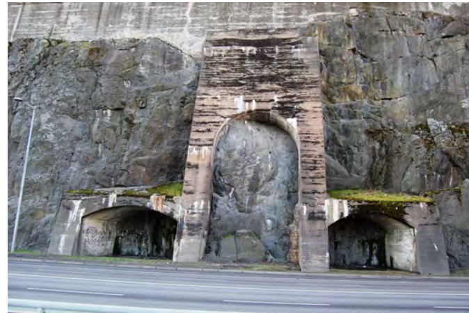
Avsnitt av bergsskärningen vid Stadsgården med kontreforer av armerad betong. Här är berget kraftigt bearbetat.
