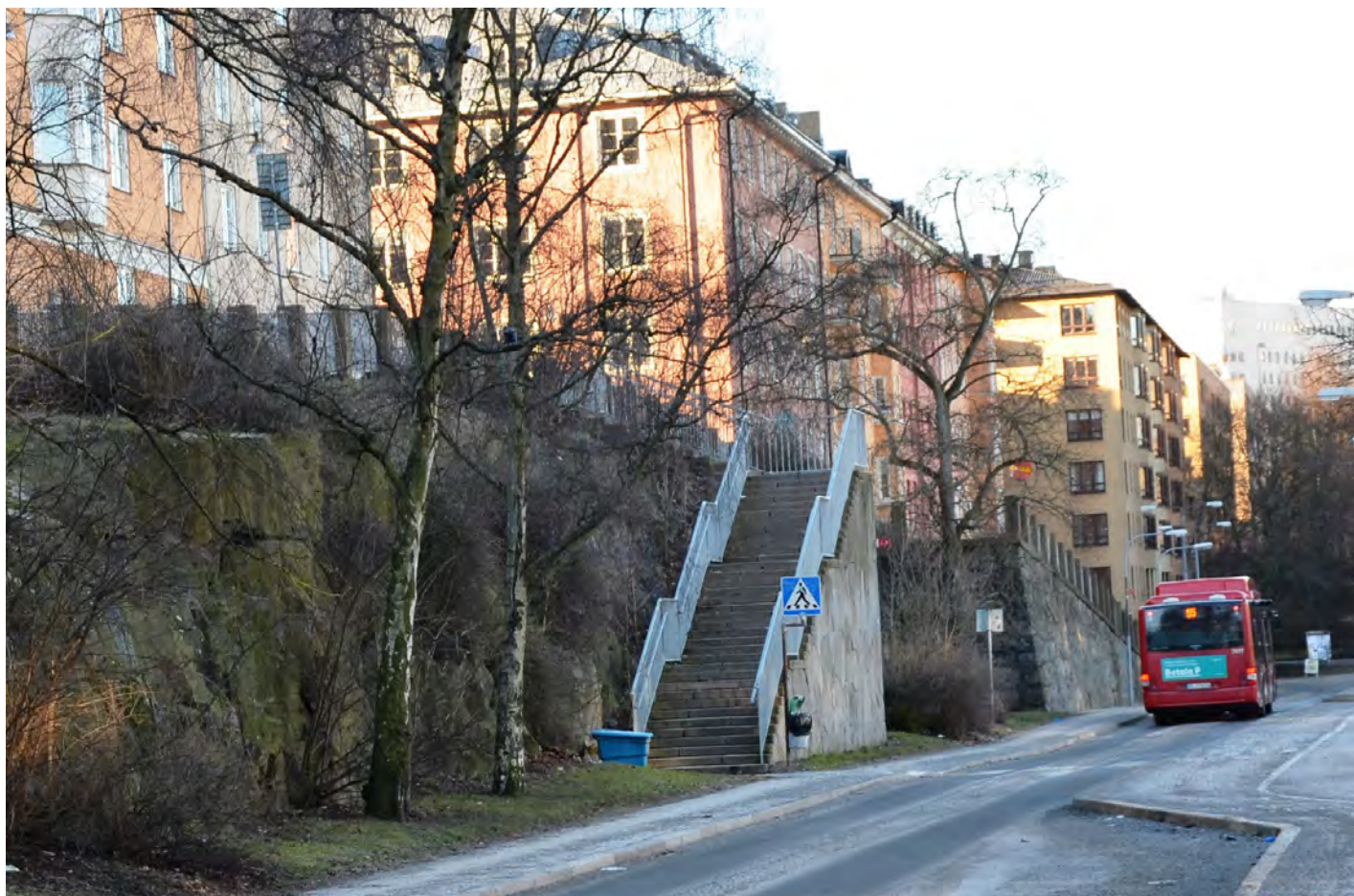
Bergsskärning i förgrunden och i bakgrunden mur mot Rosenlundsparken. Trapparrangemanget mitt i leder från parken upp till Hallandsgatan.
