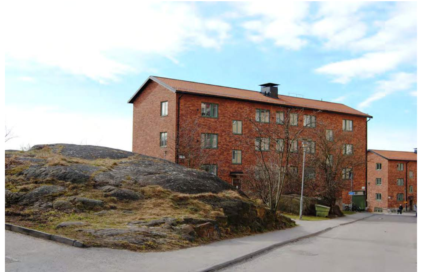
Förgårdsmark Kv Strängen, Krukmakargatan, där smalhusen ligger fint inplacerade med bevarade bergshällar mellan husen.
