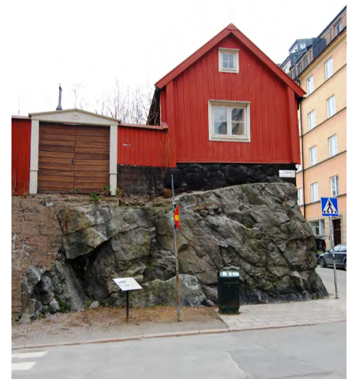
Bilden visar hur en äldre generation bebyggelse med sitt gatunät förvandlats till en enklav då bergsskärningar sprängts fram både åt väster för Sägargatans framsprängande och åt söder längs Åsögatan. Den högt belägna gårdsporten har ursprungligen mynnat i en högre belägen gatunivå.
