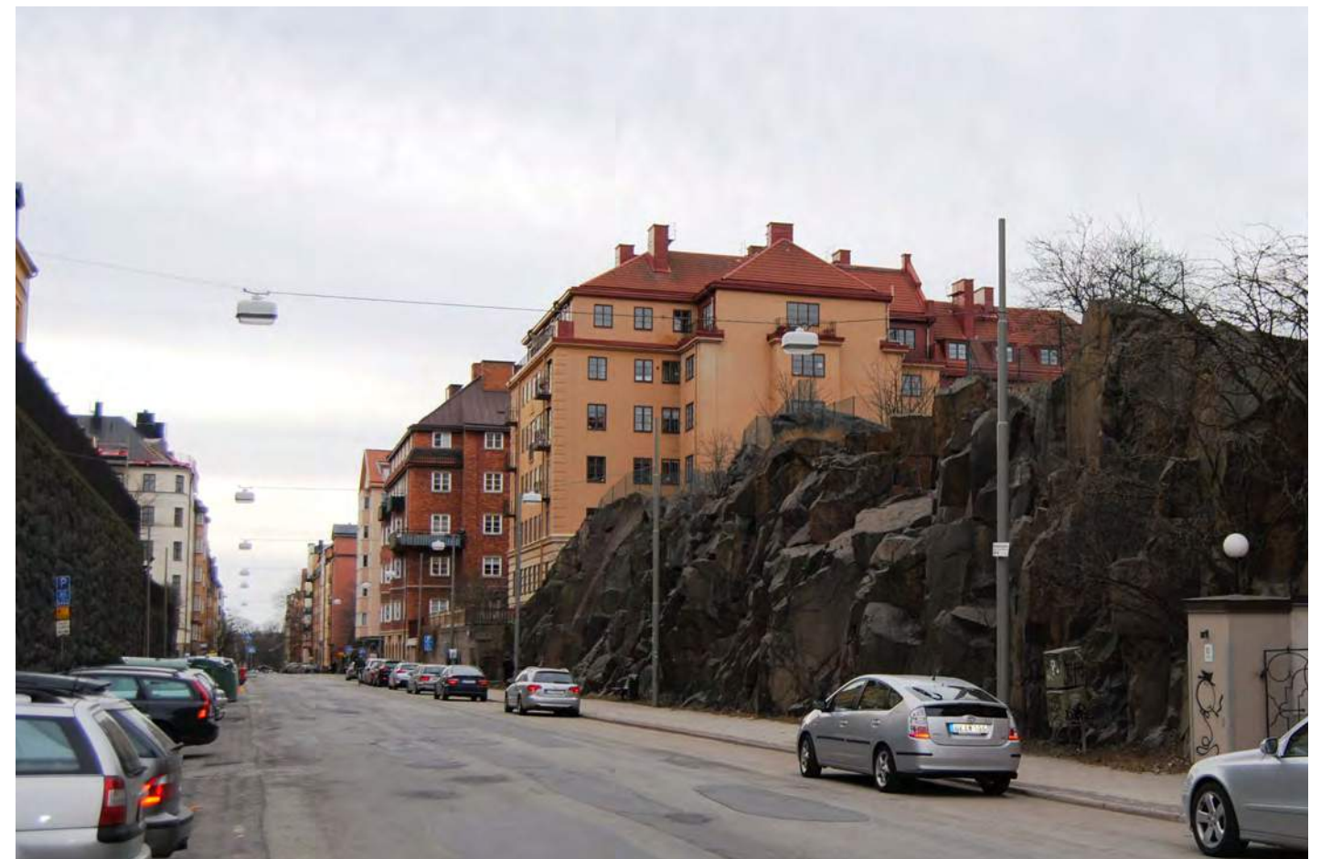
Bergsskärning mot Pålsundsberget längs med Heleneborgsgatan. I Pålsundsberget drevs tidigare ett stenbrott där man bröt gatsten för stadens snabba utveckling. Pålsundsberget är idag naturminne.
