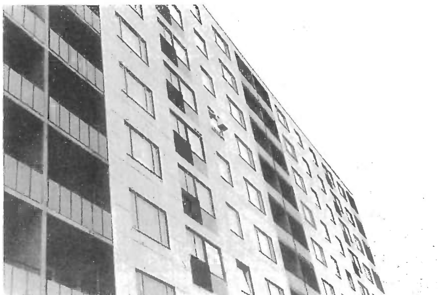
Fig. 4. Husfasaden mot söder med termografbur och solarimeter.
