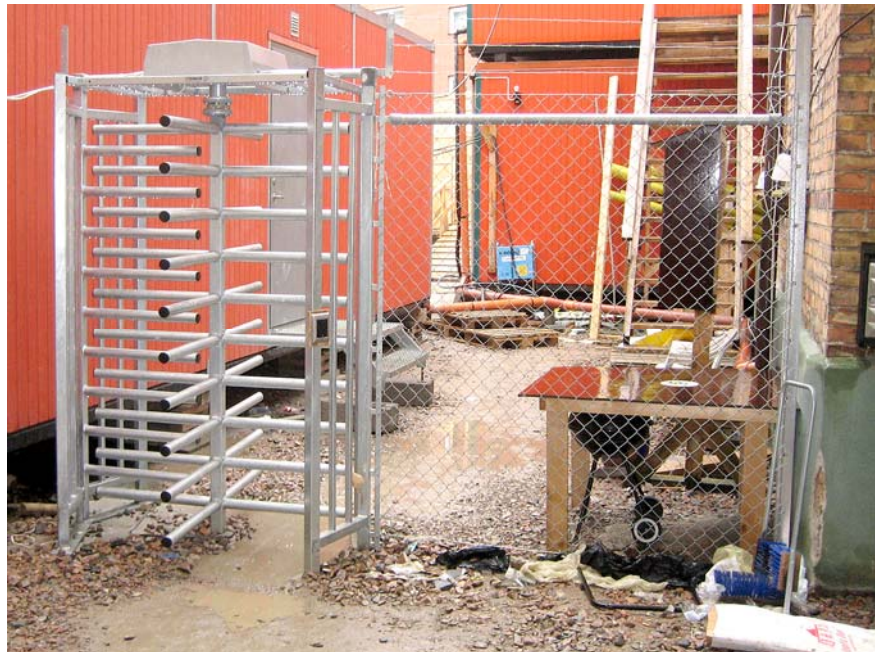
Figur 8 Samtliga som arbetar på bygget blir automatiskt registrerade via en snurrgrind på väg in till arbetsplatsen.
