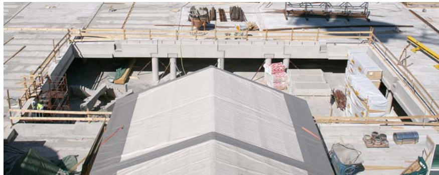
Figur 10 Hålet i gårdsbjälklaget utnyttjades för att lyfta ner material till källaren för att skydda lagrat material.
