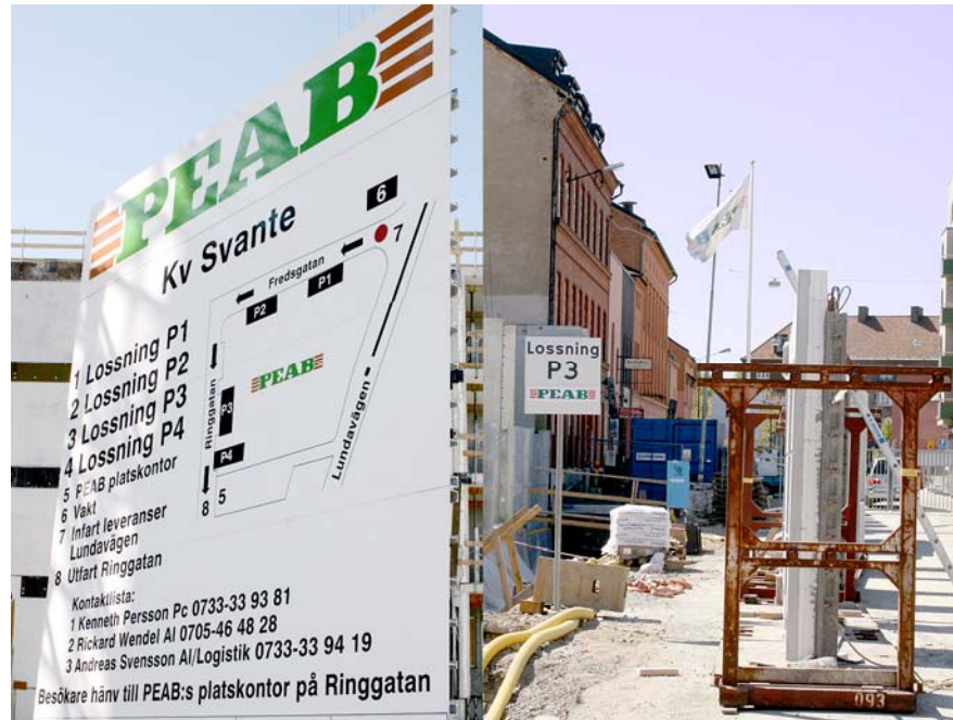
Figur 14 Tydliga skyltar visade var leveranser ska lossas och telefonnummer till projektets logistikansvarige och annan behjälplig personal.
