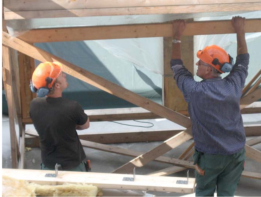
Figur 21 Byggarbetarnas trivsel påverkar i högsta grad såväl projektets logistik och lönsamhet.
