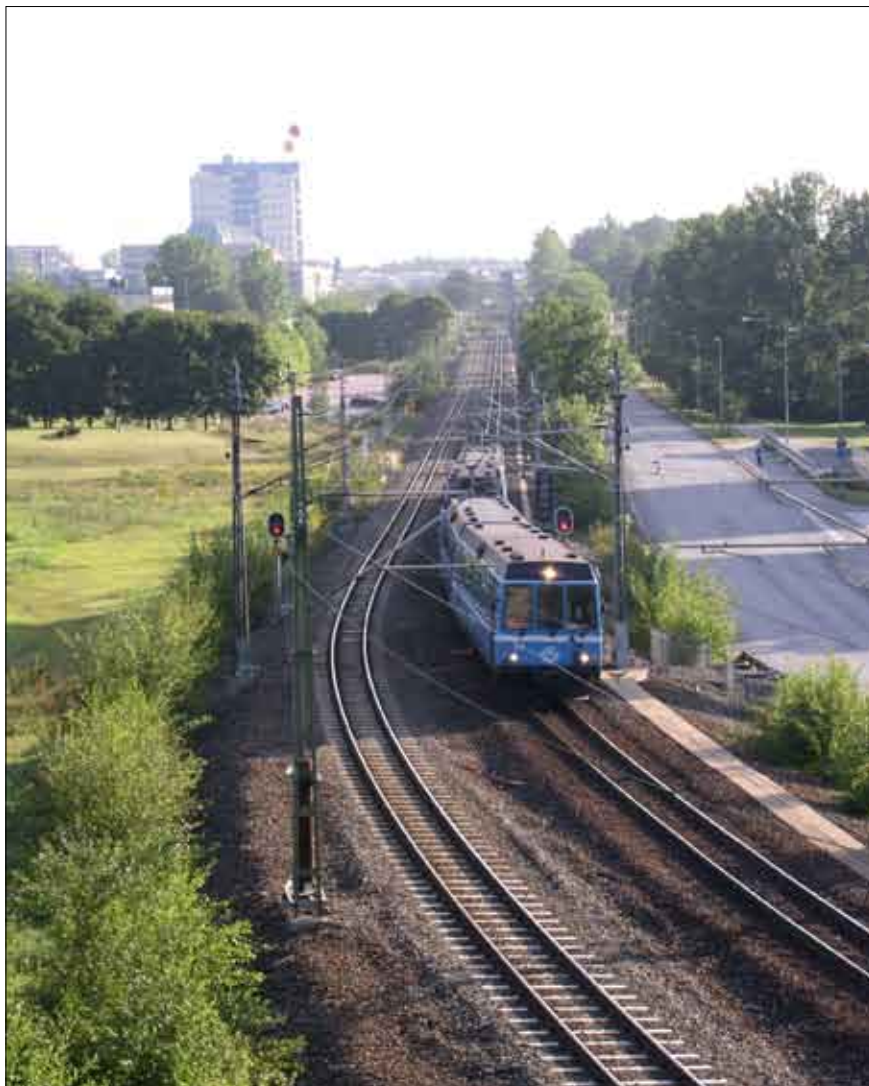
Roslagsbanan med dubbelspår är viktig för pendlare. Banan har dock endast enkelspår i Vallentuna kommun.
