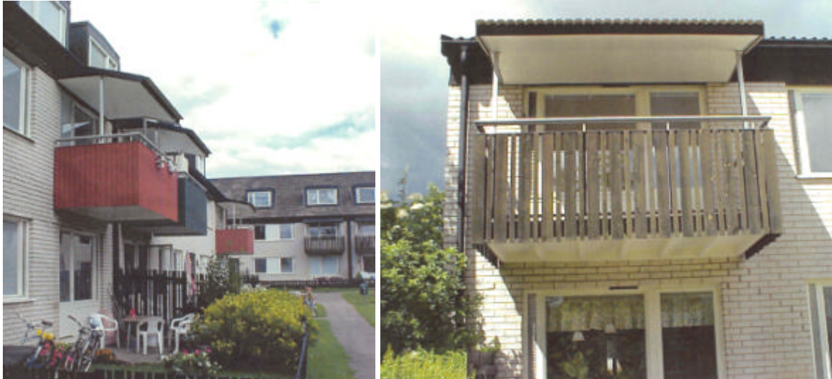
Skäggetorp, t v Utbytta balkonger på grannfastighet, t h balkonger i originalutförande Foto: Stadsbyggnadskontoret, Linköping
