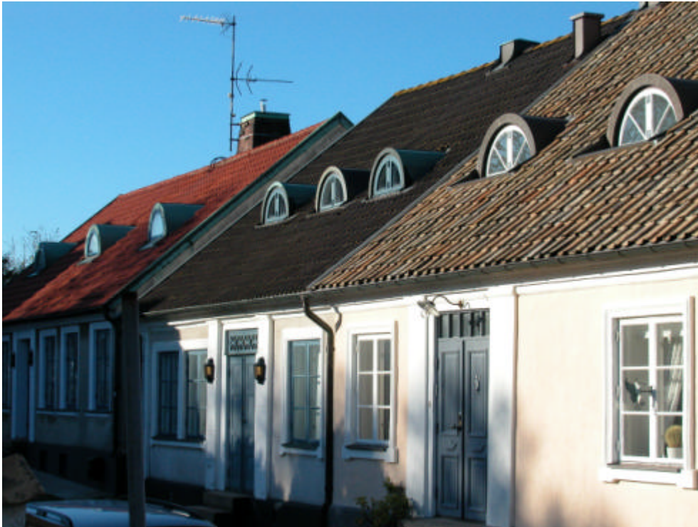
I mitten kv Stranden 8. Enligt kammarrätten var det förenligt med 3 kap 1 § att förse huset med en tredje takkupa. Foto: Göran Hagsund 2004.
