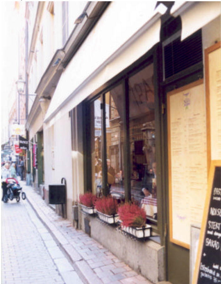
Kv Latona 9. Uppdelning av glasytan medförde inte förvanskning. Foto: Otto Ryding
